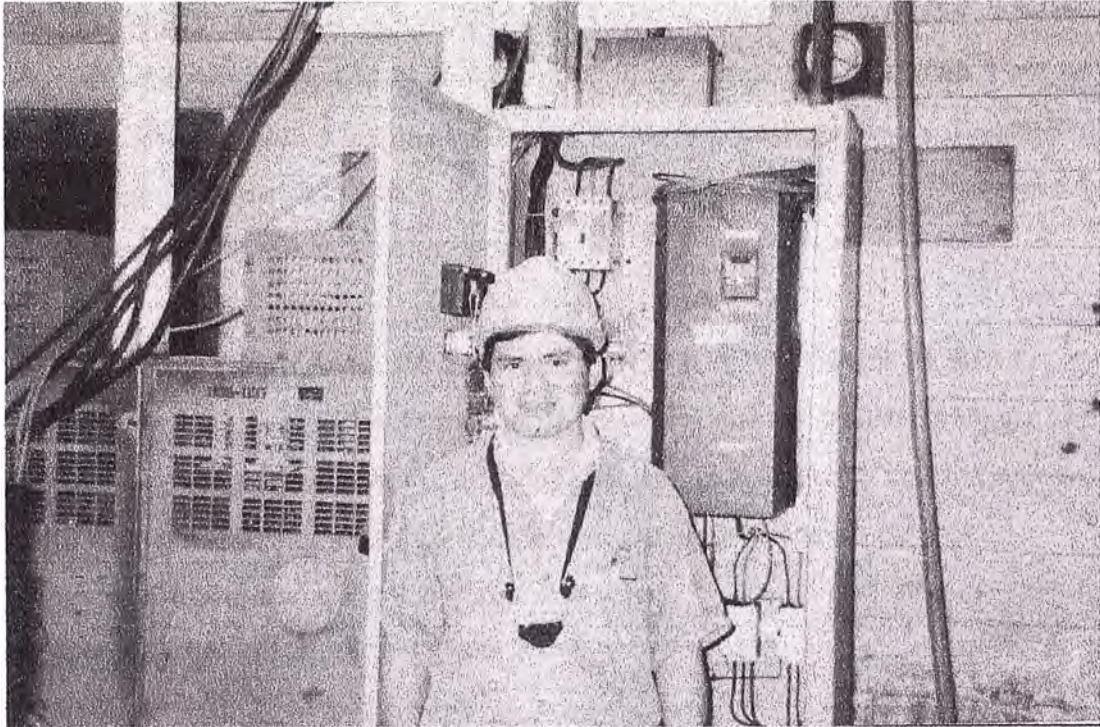
Figura 5.5: Montaje de un variador de velocidad.
