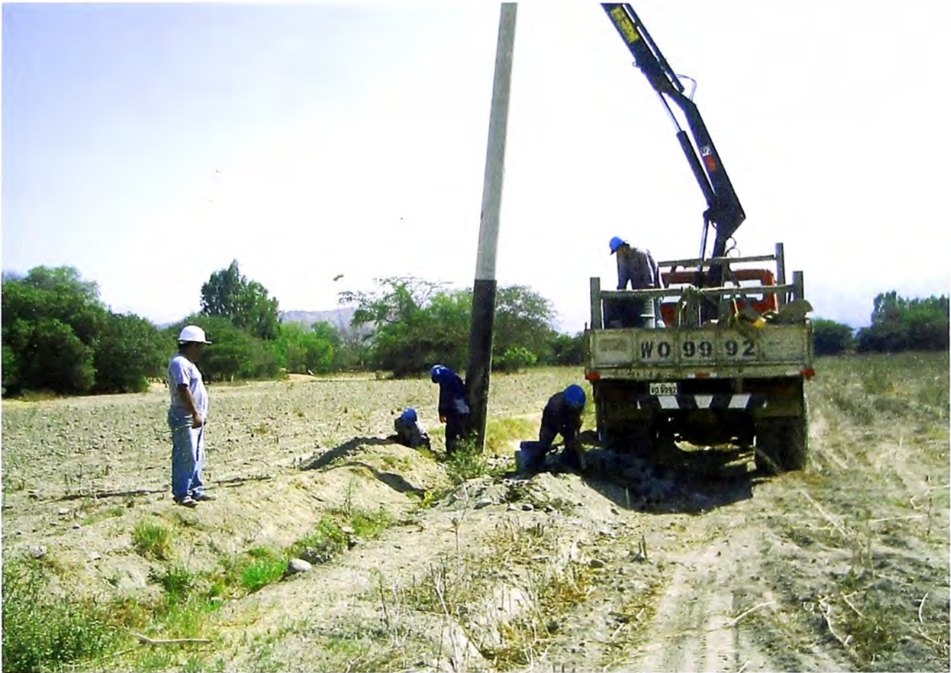
c.2 Proceso de Izado de Poste de Concreto
