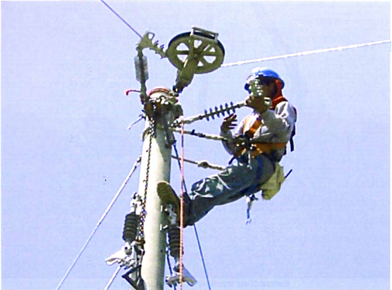
c.1 Proceso de Instalación de Armado y Tendido de conductor en estructura de anclaje.
