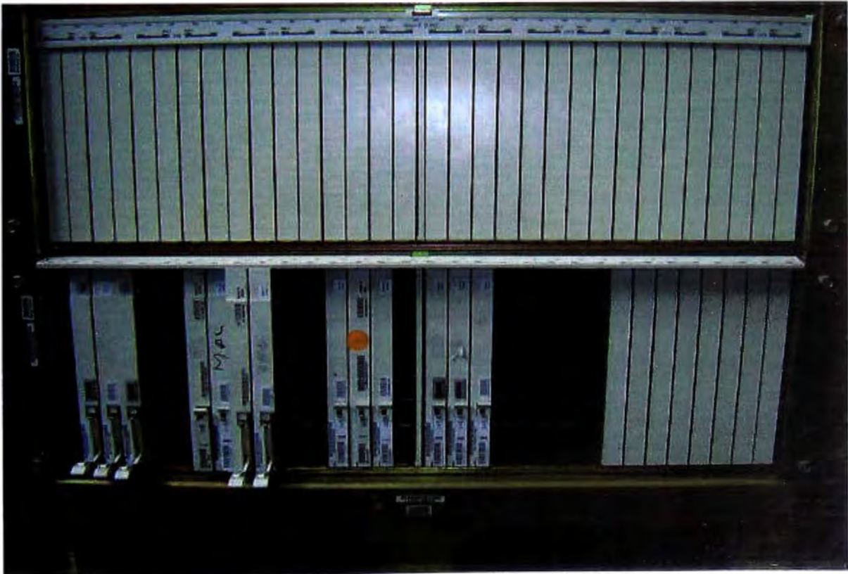
Magazín de abonados del tipo MPA 3B y MPA 23
