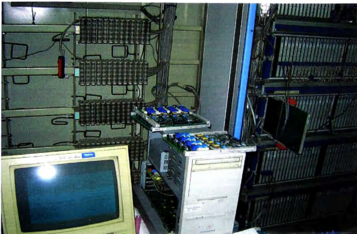
URA AXE con interface hombre- maquina
