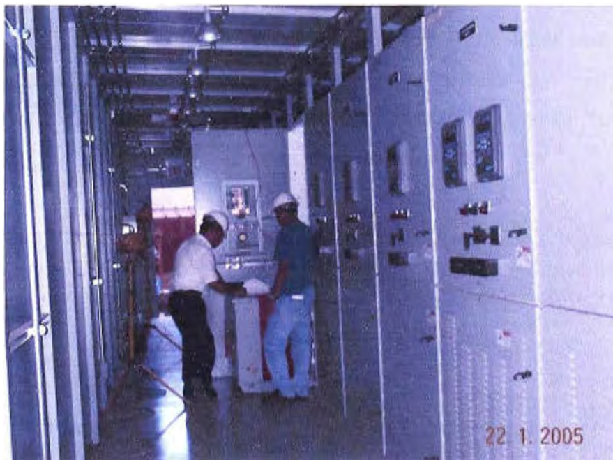
VISTA INTERIOR DE WALKING – SUPERVISION EN CAMPO
