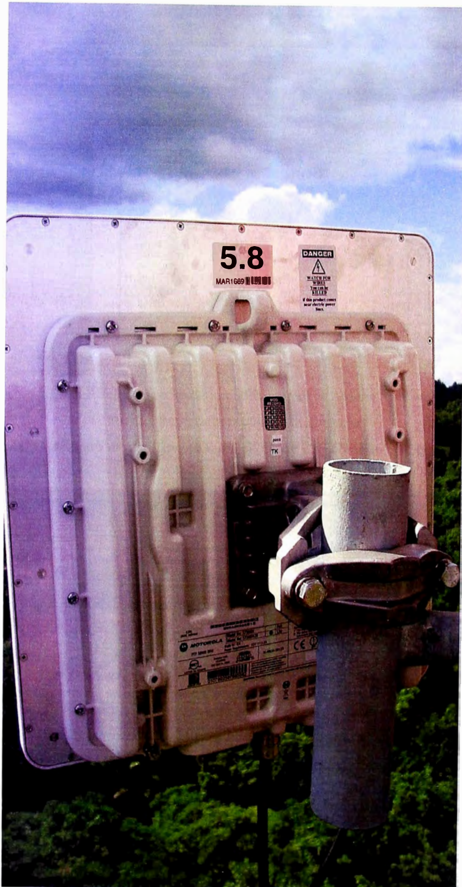
Fig.3.10 Instalación de la Antena
