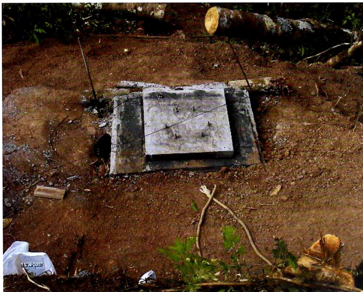
Fig.3.5 Construcción de Soporte para Torre
