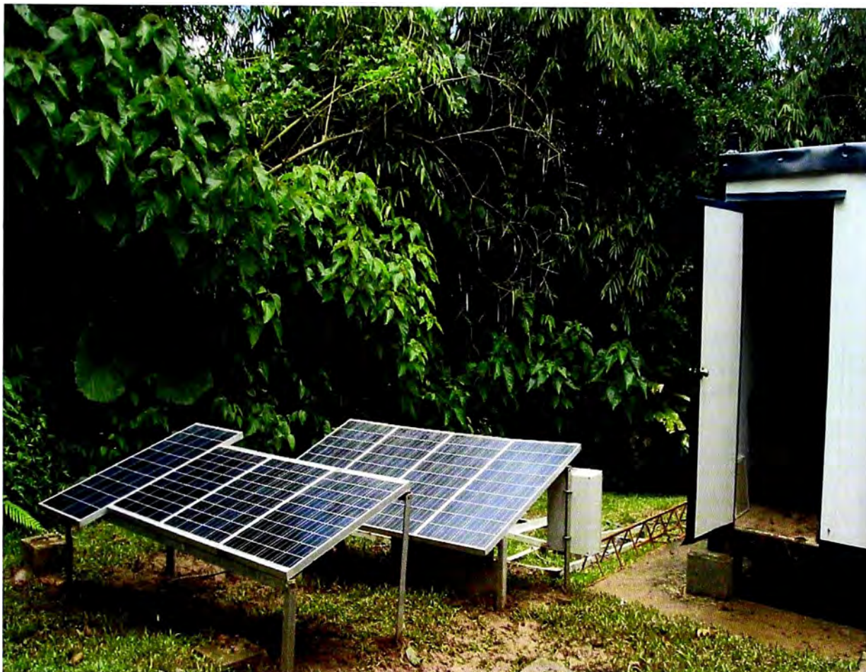
Fig.3.8 Instalación de Paneles Solares
