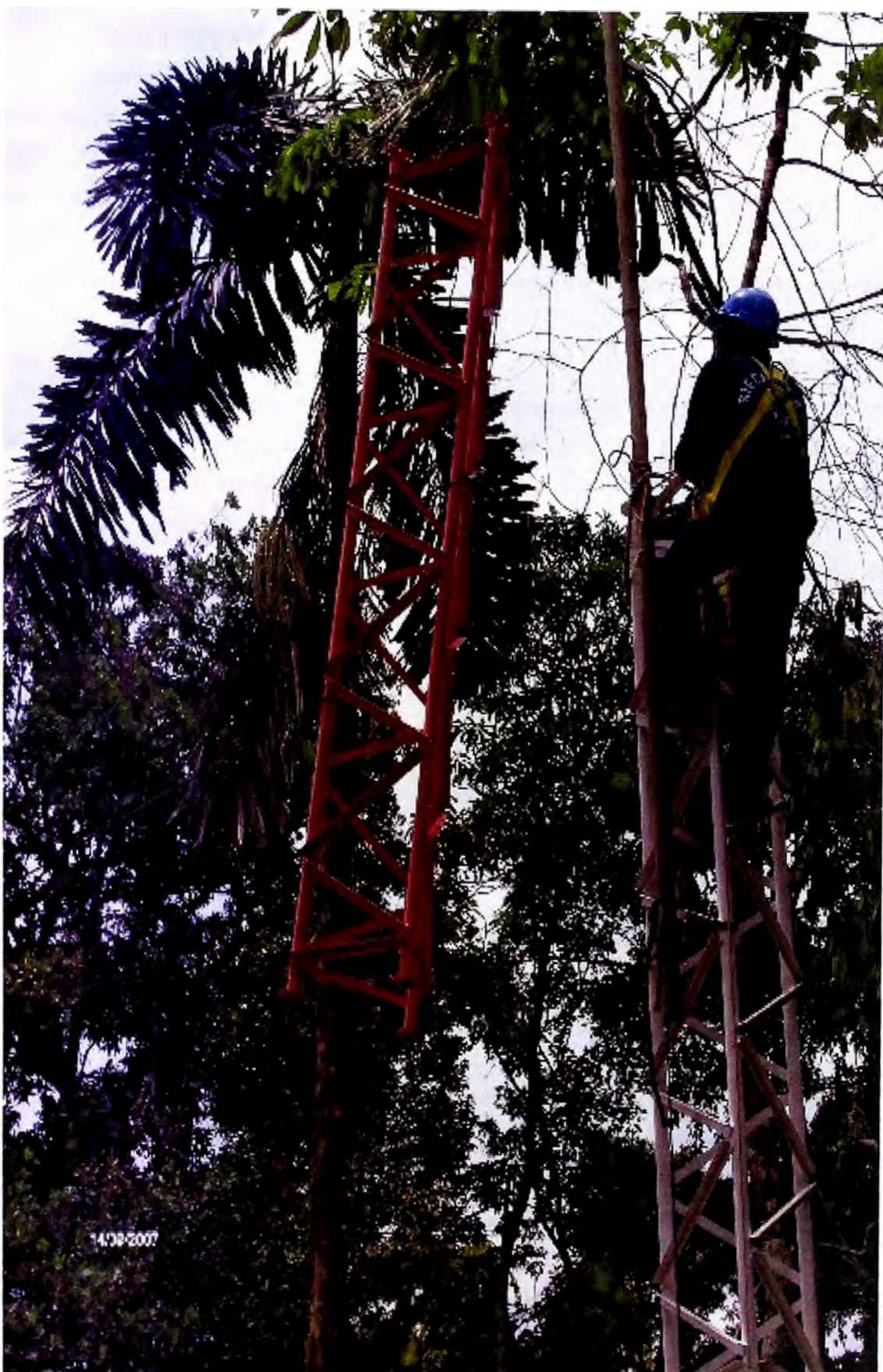
Fig.3.7 Instalación de Torre de Telecomunicaciones
