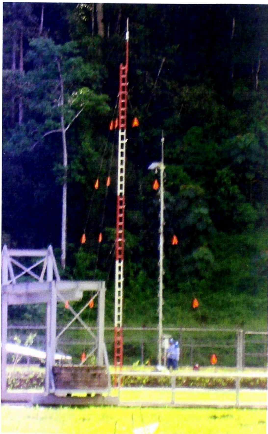
Fig.2.19 Ejemplo de torre Atirantadas
