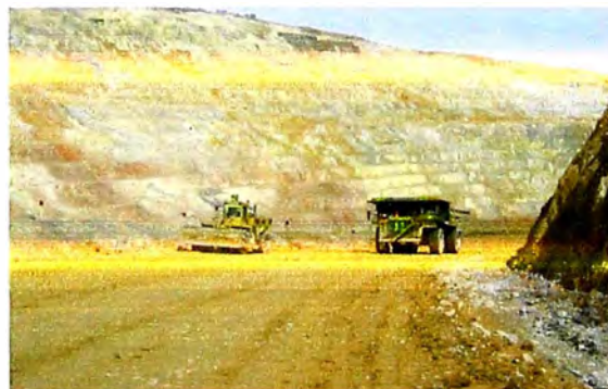
Figura 4.22-Mantenimiento de la vía dentro del tajo
