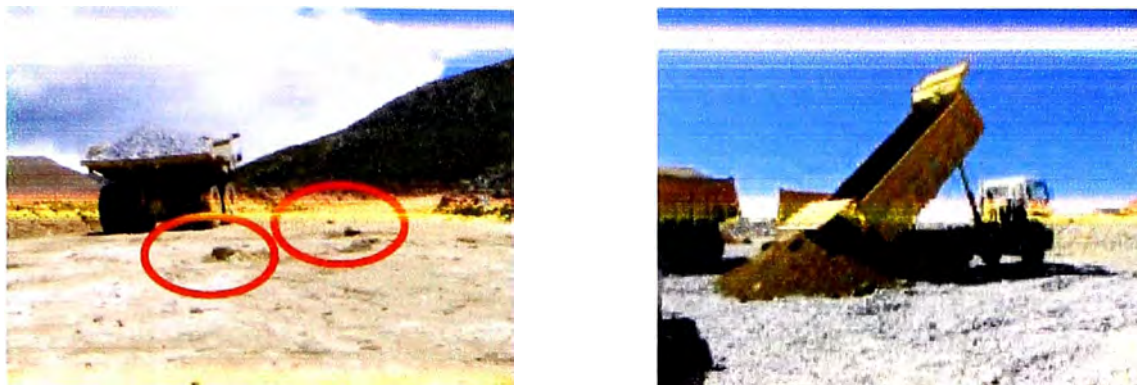
Figura 4.67- Condiciones que afectan en la zona de descarga
