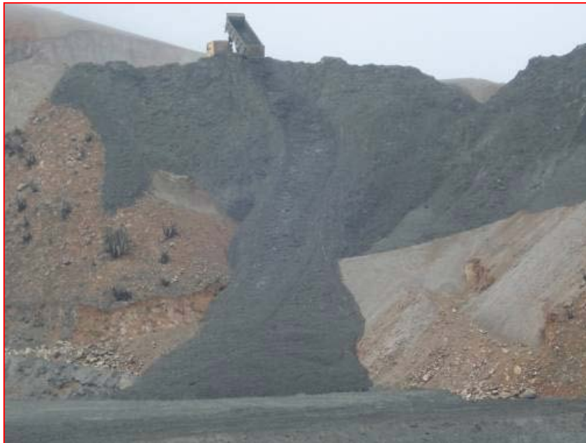
Figura N°2 Botadero de relaves. Estos relaves son depositados para que puedan secarse. También no se pueden depositar en las plataformas, debido a que los camiones no consiguen transitar.
