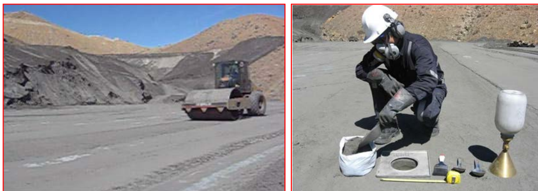
Figura N°9 Compactación del relave y pruebas de compactación in situ
