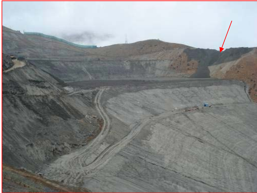
Figura N°1 Vista general del depósito, con las plataformas 1 y 2. Arriba y a la derecha en la foto observar el botadero de relaves por sobre la plataforma 1.
