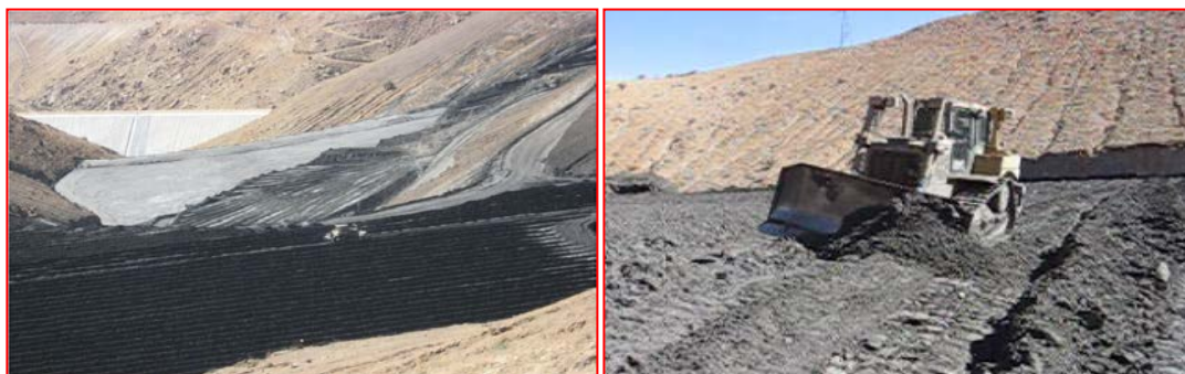
Figura N°8 Conformado y secado del relave
