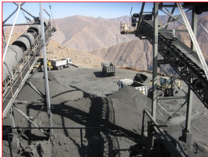
Figura N°6 Carguío de Relaves Filtrados
