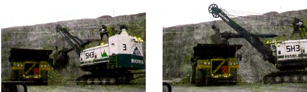
Figura 3.6: Llenado al Truck Inicio Fuente Antamina
