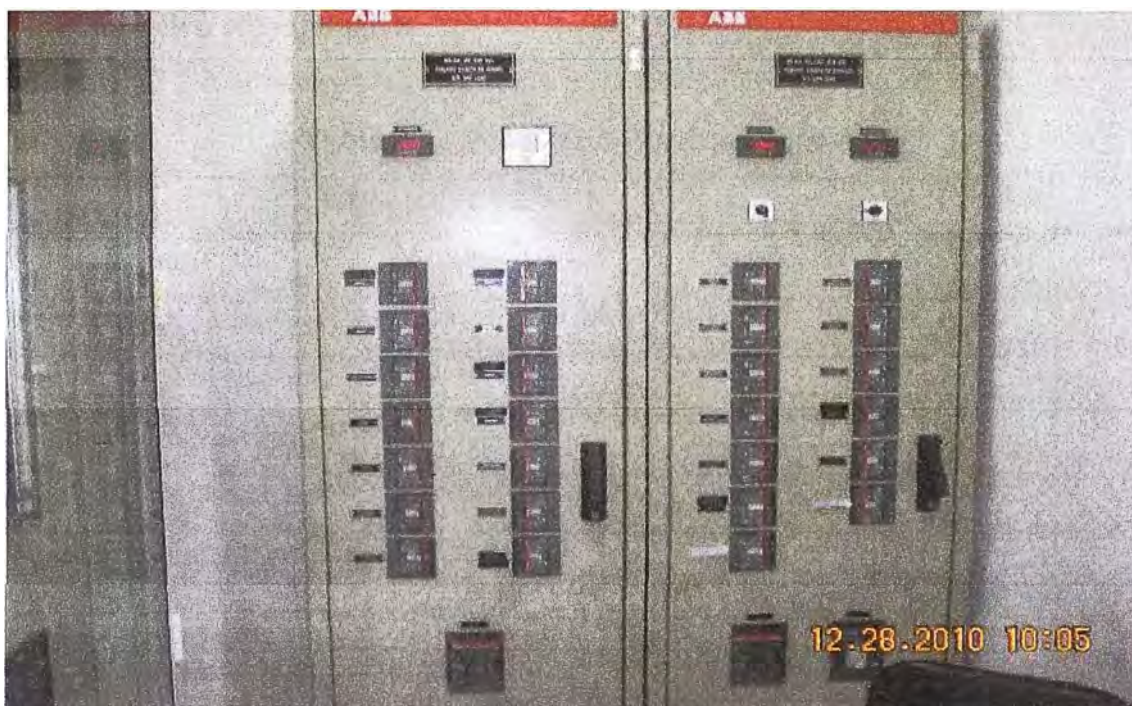
Figura 2.8 Servicio auxiliar ubicado caseta de campo en patio superior
