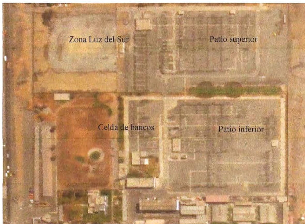
Figura 2.1 Vista aérea del patio de llaves de la S.E. SAN JUAN
