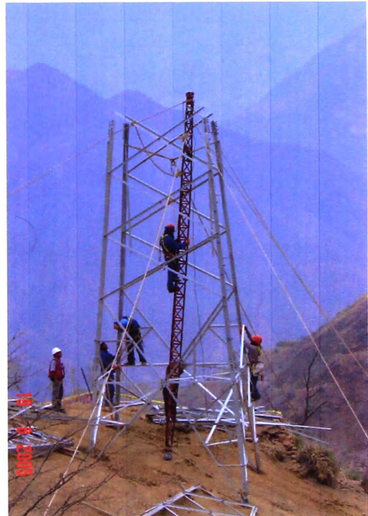
Foto N° 10: Montaje del cuerpo , utilizando una pluma liviana
