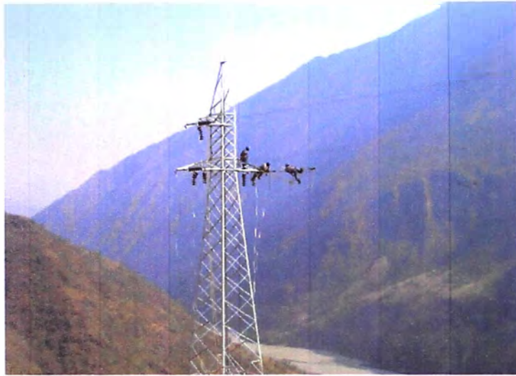
Foto N° 19: Montaje de aisladores y accesorios
