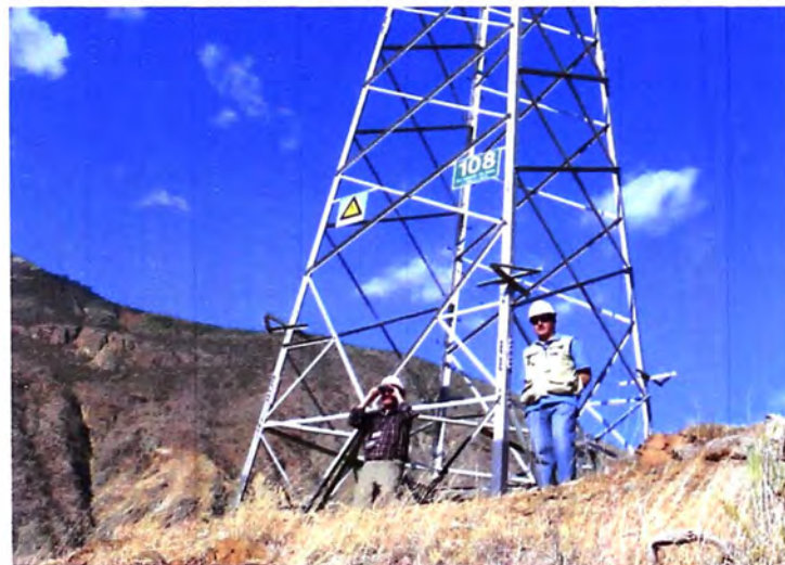
Foto N° 24: Vista final antiescalamiento, codificación y señalización
