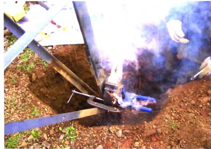
Foto N° 15: Empalme mediante soldadura exotermica
