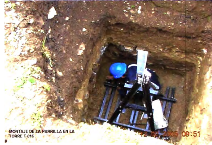
Foto N° 2: Instalación y montaje de parrillas
