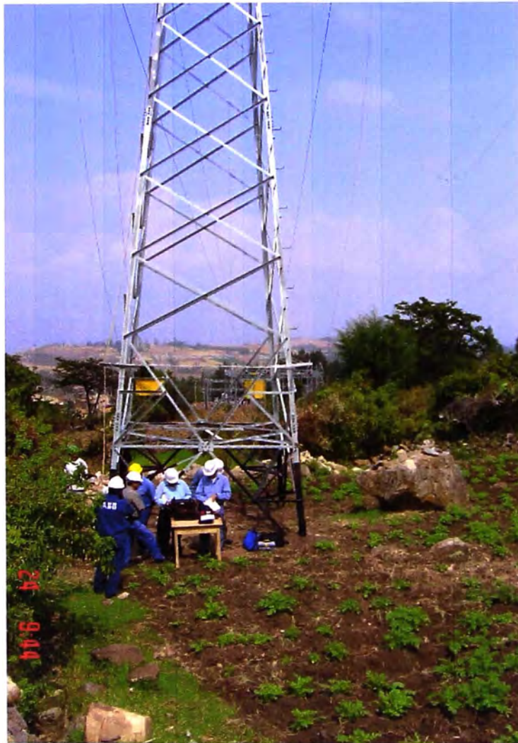
Foto N° 27: Inicio de Pruebas de Puesta en Servicio Torre T-001
