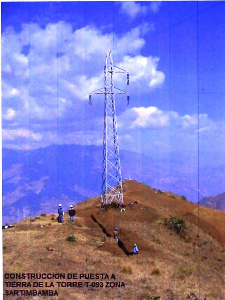
Foto N° 13: Montaje de la puesta a tierra
