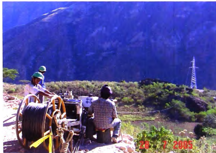
Foto N° 18: Tendido de conductores - Operación del Winche
