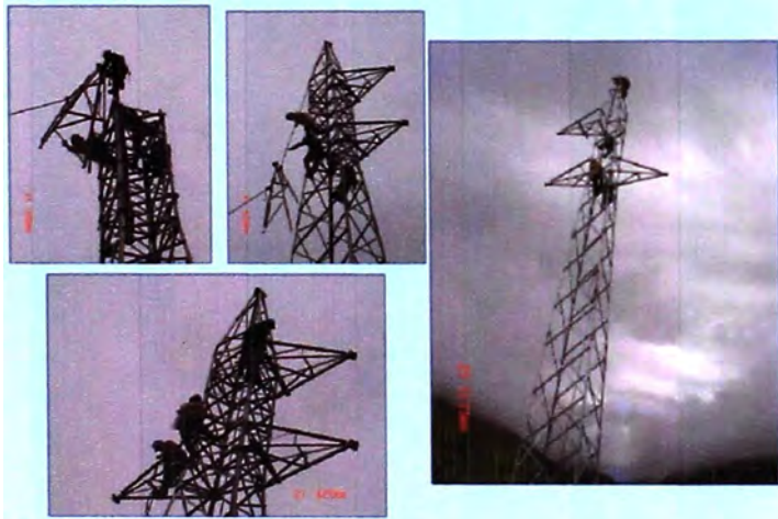
Foto N° 11: Montaje de brazos y castillete
