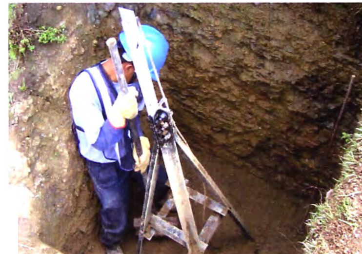
Foto N° 4: Compactación de parrillas
