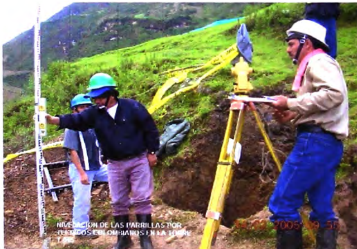
Foto N° 3: Nivelación de parrillas
