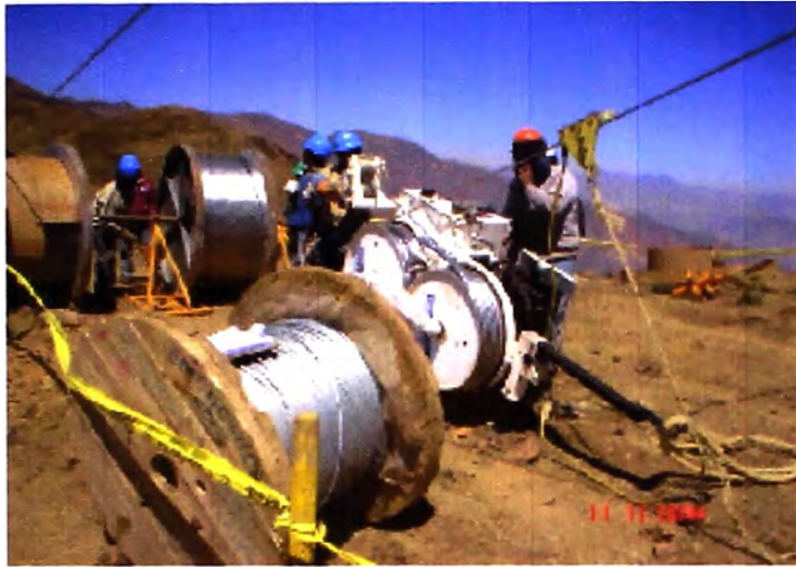
Foto N° 16: Tendido de conductores - Operación del Freno
