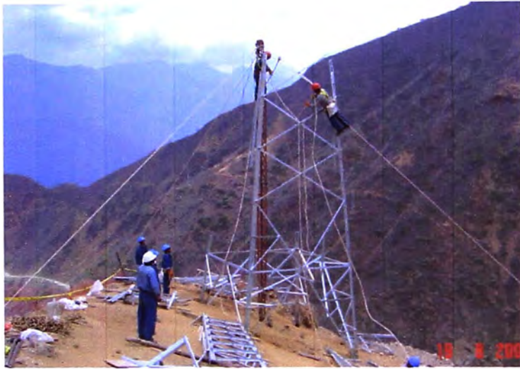
Foto N° 9: Montaje de patas y cuerpo de torres
