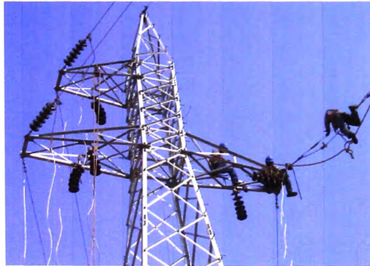
Foto N° 21: Regulación del conductor y cable de guarda
