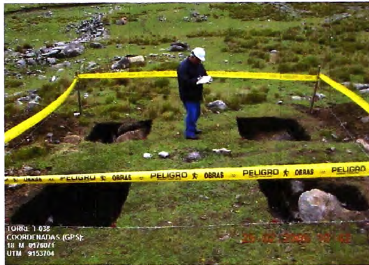
Foto N° 1: Marcación y excavación de parrillas
