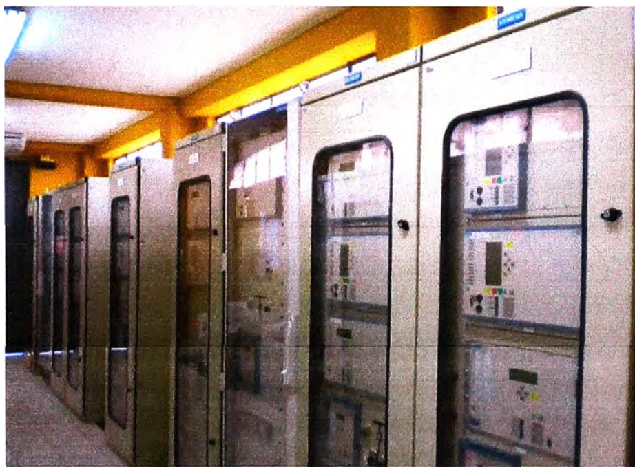
Fig. 2.2 Nivel de Control de Bahía.
