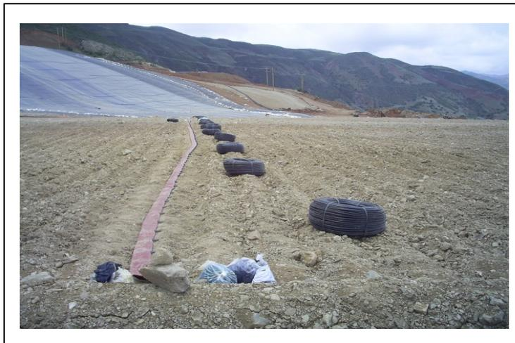
Figura 5.9. Manguera lay flat de 4". Lateral hydromine de 16mm-1.6 l/h
