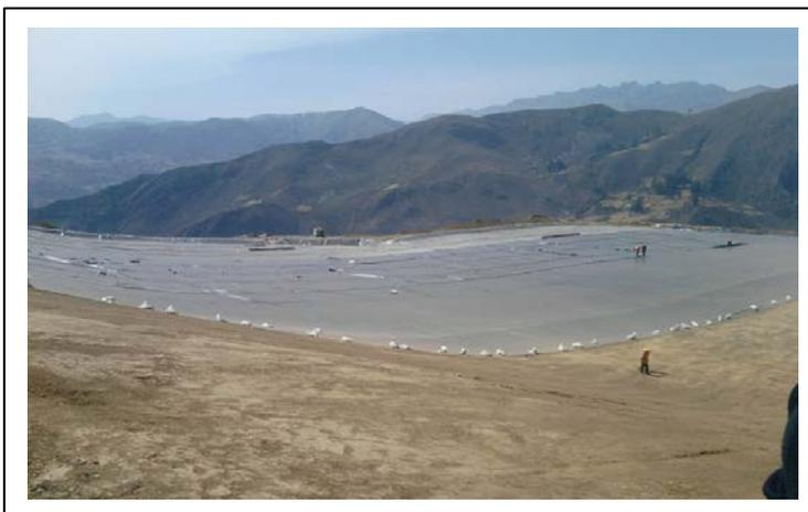
Figura 5.2. Extensión de geomembrana sobre la capa de arcilla
