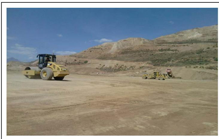
Figura 5.1. Extendido de la capa de baja permeabilidad (Soil liner)
