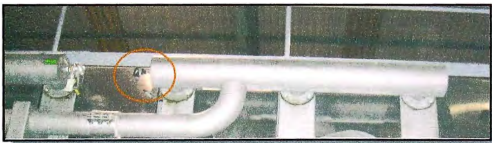
Fig. 3.9. PT100 De Tanques de Lluvia. Ítem 21
