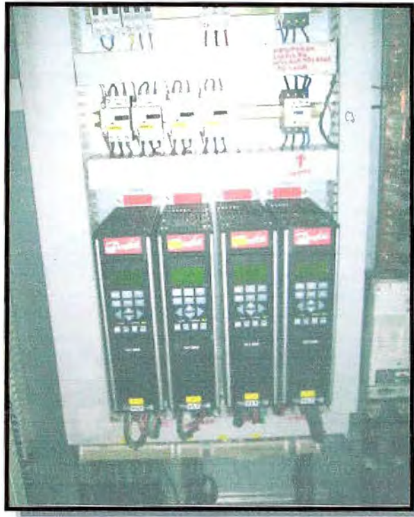
Fig. 3.3. Variadores de Moto reductores de Pisos y de Entrada- Ítems 2 y 4
