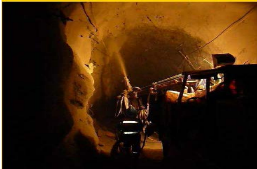
Figura. 5.5- equipo Robot Alpha lanzando shotcrete preventivo
