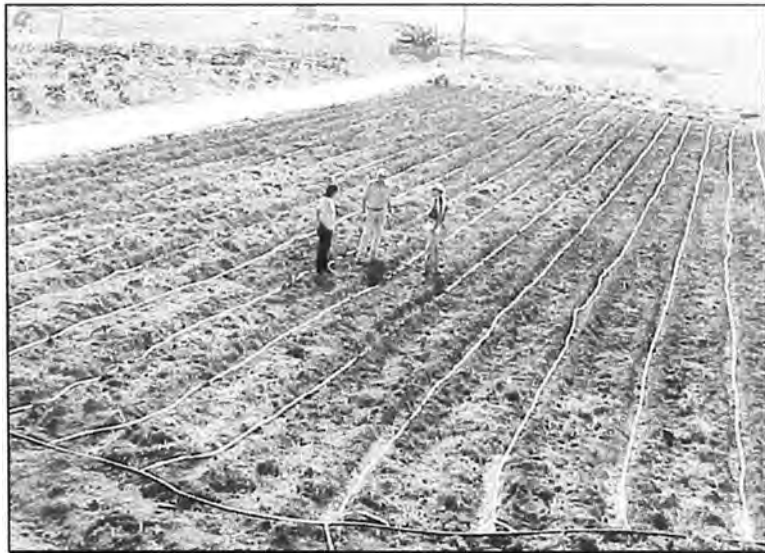
Figura 2.5 Instalación de riego por goteo.
