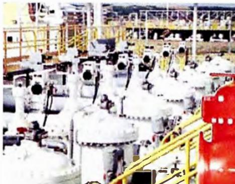
El mayor de los medidores PD de Smith, el M-16 (16"; 40,64 cm) puede verse aquí, instalado en uno de los mayores sistemas de transferencia comercial de crudo en Norteamérica.
