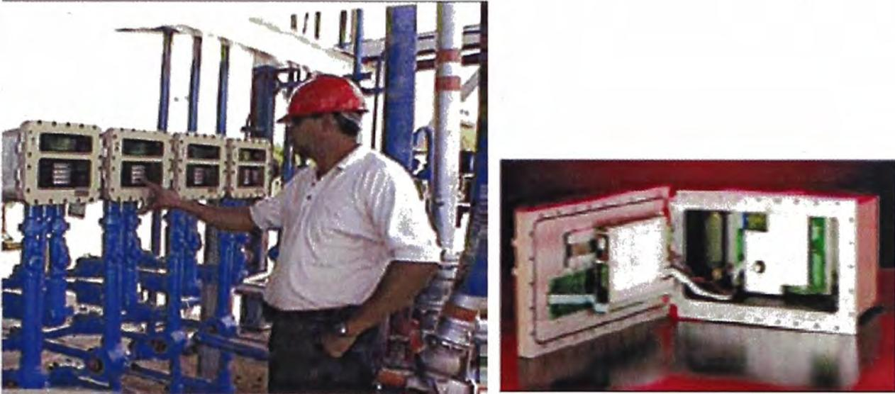
Figura 2.17 Panel del puente de despacho de combustible con controlador de Carga Accuload II y III.
