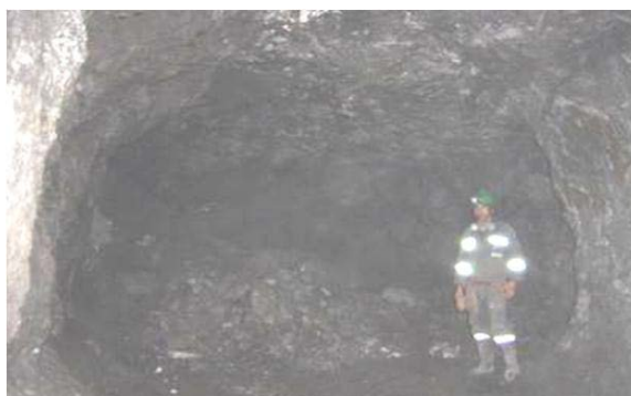
Figura 3.21.- Estallido de roca Cuerpo Rosario
