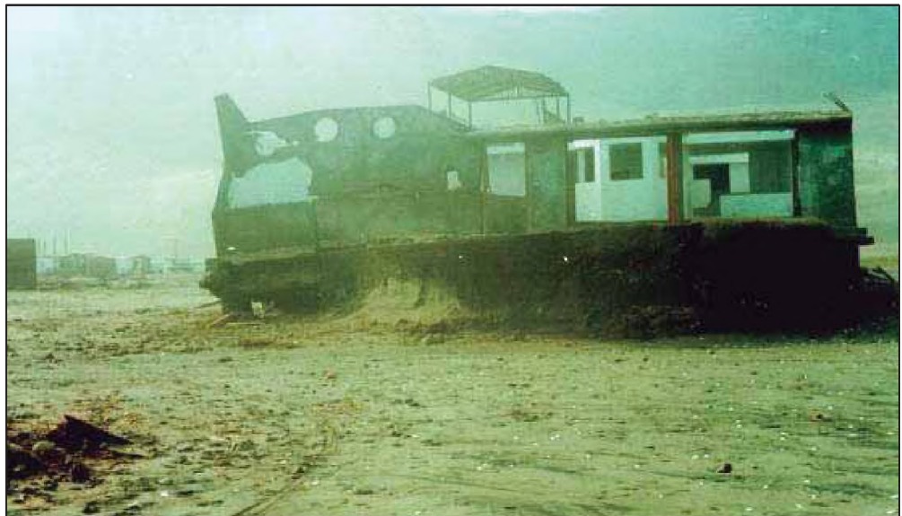
Foto N° 3.1 Daños producidos por Socavamiento en el Balneario de Camaná por el Tsunami.
