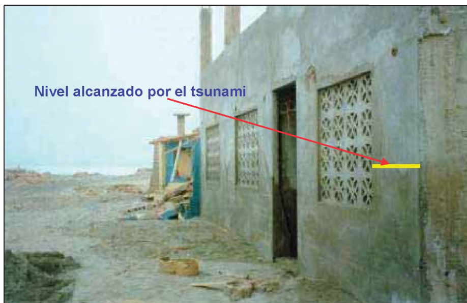
Foto N° 7.43.- Zona del Balneario de Las Cuevas. Se observa el nivel alcanzado por la ola del tsunami.
