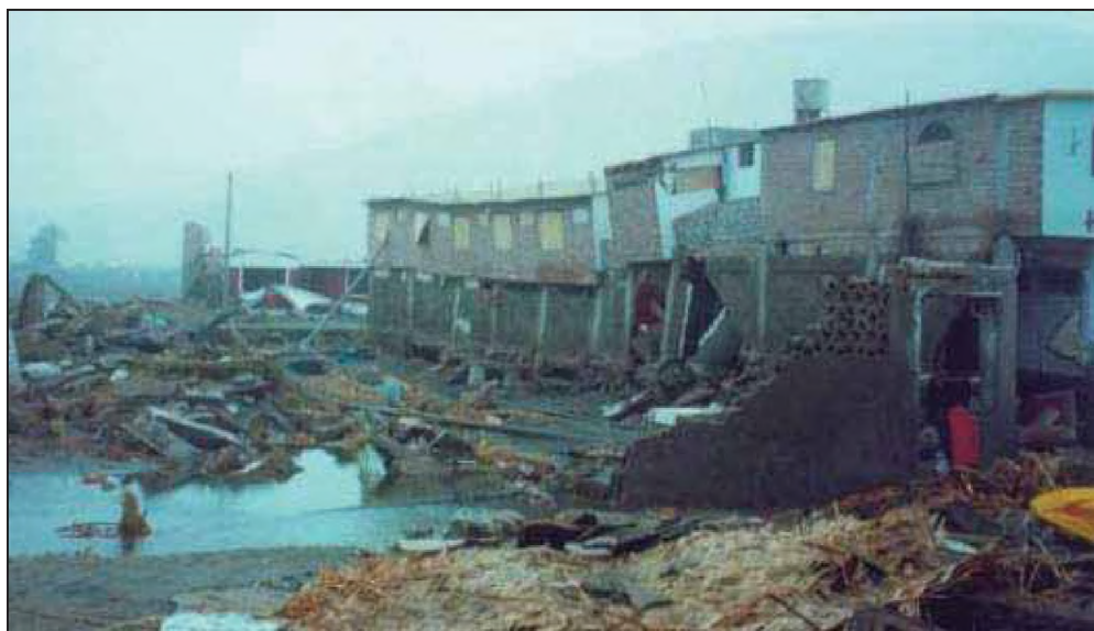
Foto N° 3.3 Daños producidos por Fuerzas de Oleaje en el Balneario de Camaná por el Tsunami
