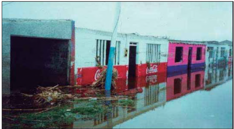
Foto N° 3.6 Daños producidos por Fuerzas Hidrostáticas
