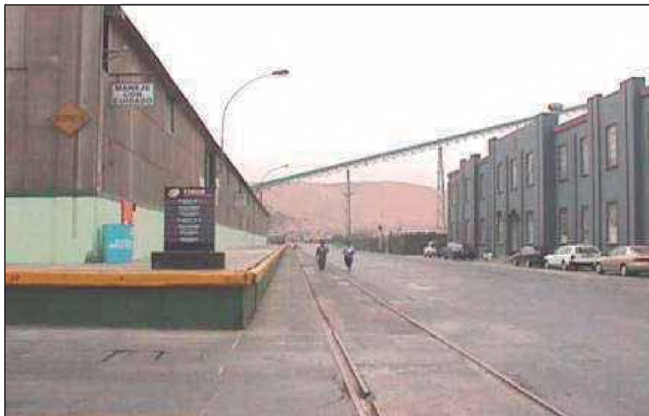
Foto N° 7.50.- Recorrido de la nivelación en el Puerto de Matarani y efectuando reconocimiento de posibles evidencias del Tsunami.
