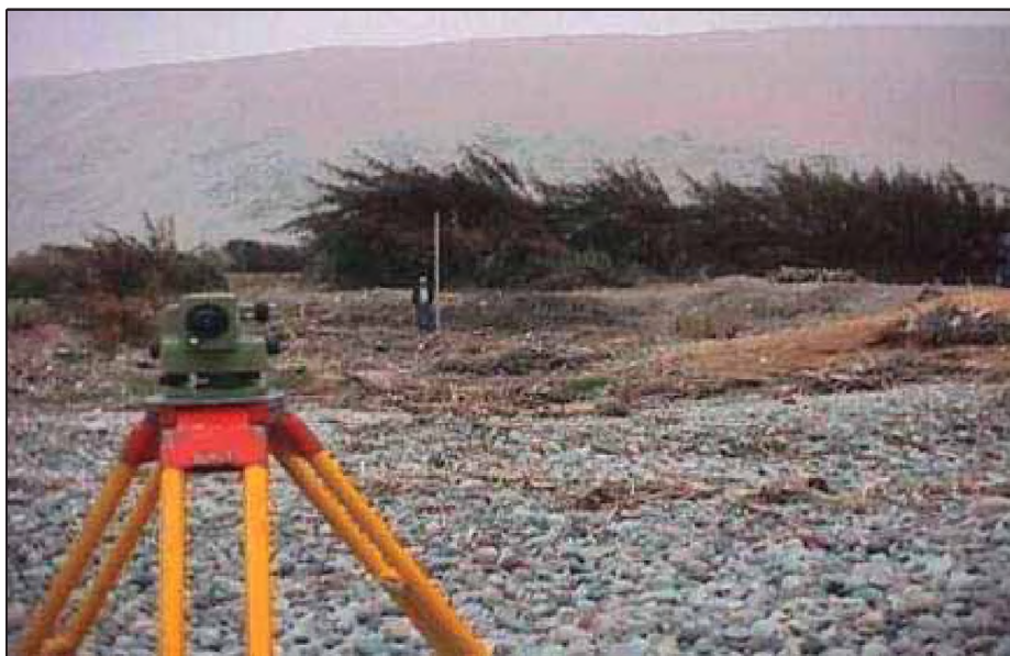
Foto N° 7.21.- Personal realizando mediciones de pendiente de playa (Nivelación taquimetrica) Ocoña.
