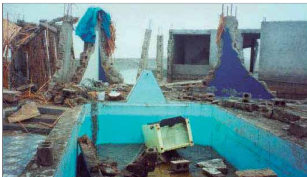
Foto N°3.4 Daños producidos por Fuerzas de arrastre e impacto en el Balneario de Camaná por el Tsunami
