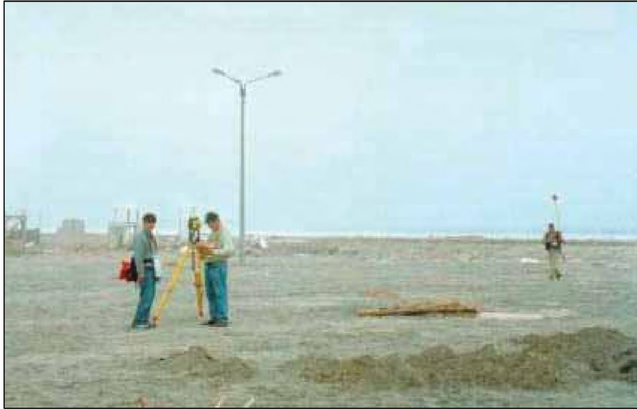
Foto N° 7.37.- Zona del Balneario de La Punta, personal realizando levantamiento del perfil de costa.
