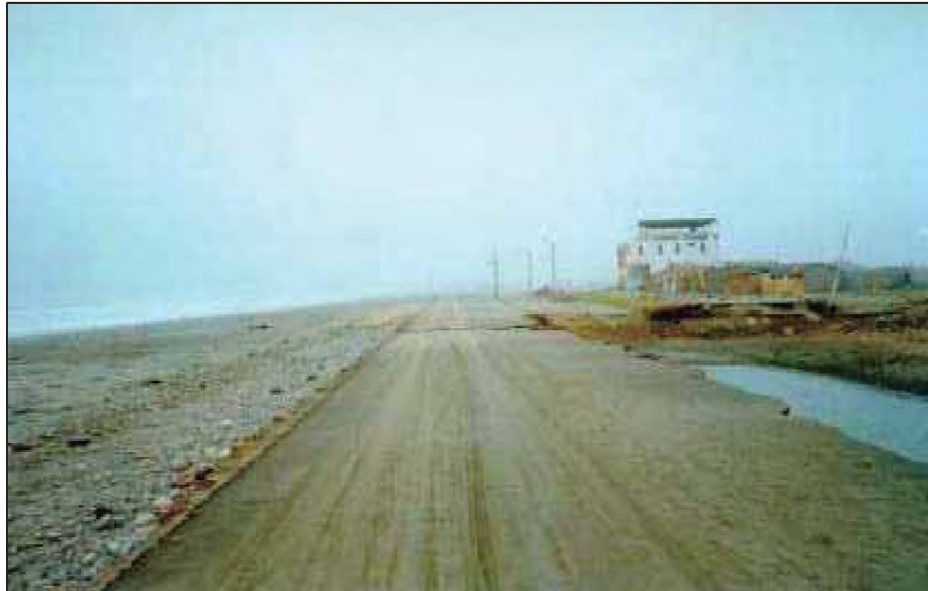
Foto N° 7.36.-Zona del Balneario de La Punta, pista costanera, totalmente destruida por el tsunami. Run-up 5.43 m.
