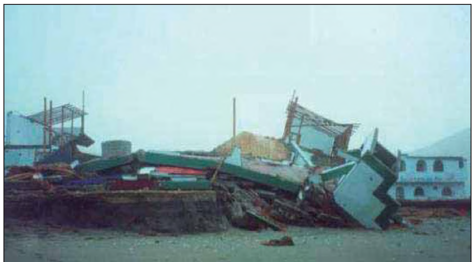
Foto N° 3.7 Daños producidos por Fuerzas de empuje
