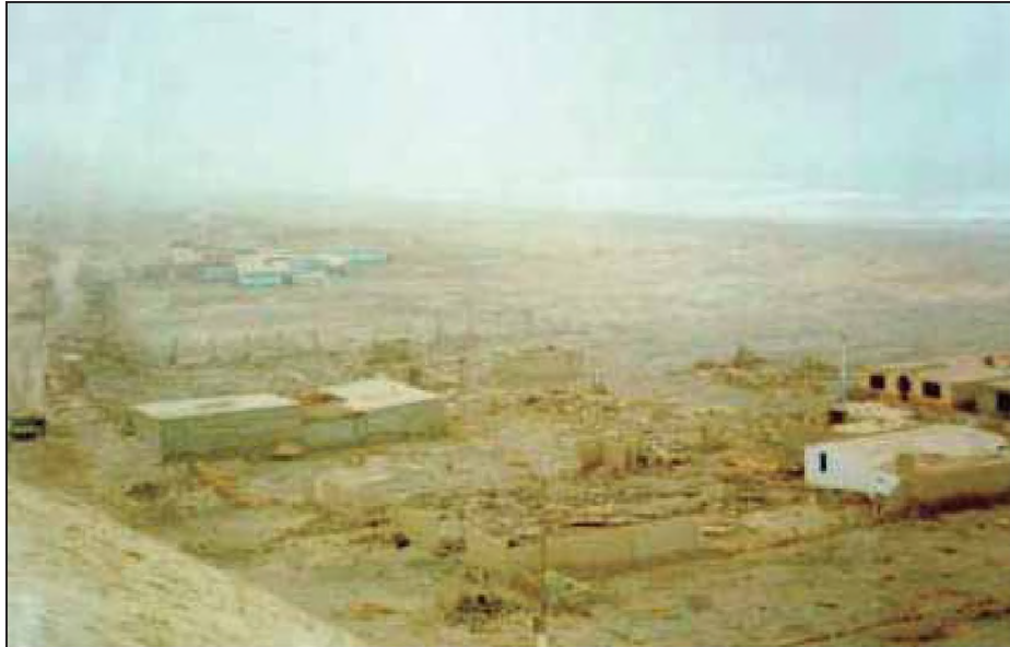
Foto N° 7.41.- Zona del Balneario de Los Cerrillos. Distancia horizontal de inundación +/- 172.60 m.
