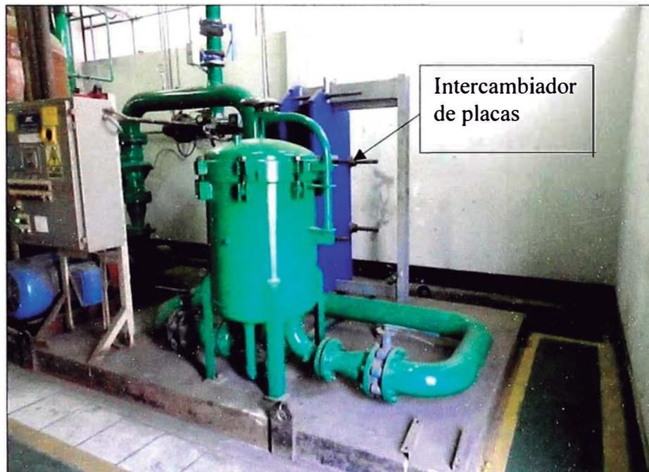
Figura N° 5.43: Circuito de EMS en la sala de Bombas. Al frente se ve el filtro (color verde) y al fondo el intercambiador de calor de placas.
