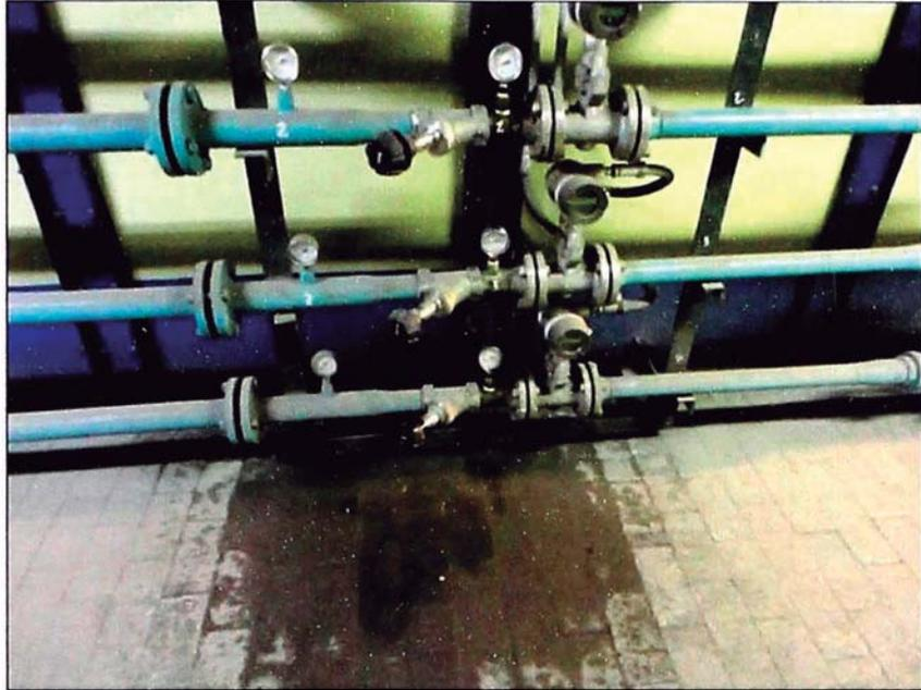
Figura N° 5.54: Fuga de agua en válvulas.
