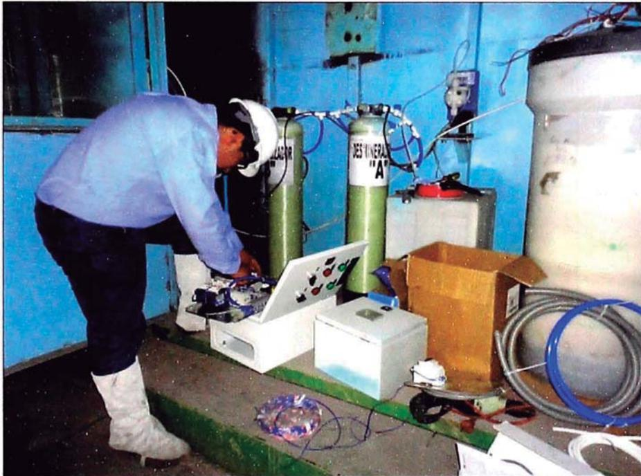
Figura N° 5.41: Instalación de tablero y bomba de stand by.
