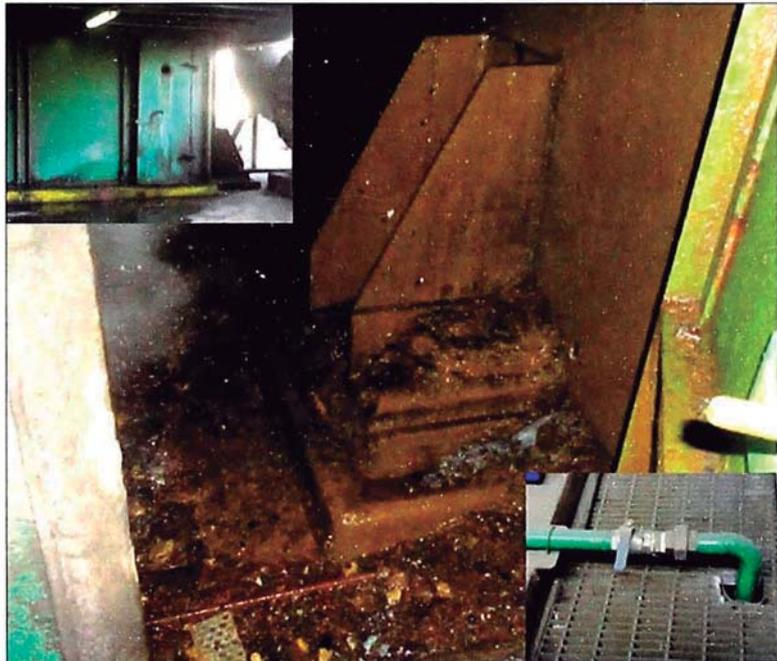
Figura N° 5.55: Fuga de agua a la salida del filtro del circuito EMS
