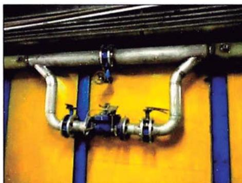
Figura N° 5.65: Válvula reductora de presión de (5 bar a 2.4 bar).
