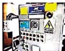
Foto 2: Equipo de medición de conductividad y temperatura.
