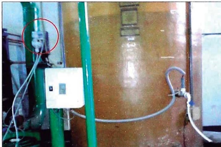
Figura N° 5.69: Bomba dosificadora de inhibidor de corrosión.
