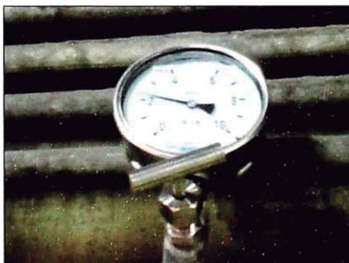
Figura N° 5.66: Presión a la salida del reductor de Presión(2.4 bar)
