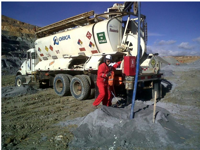
**Figura 3.2:** Proceso de carguío en forma bombeablegasificable.
