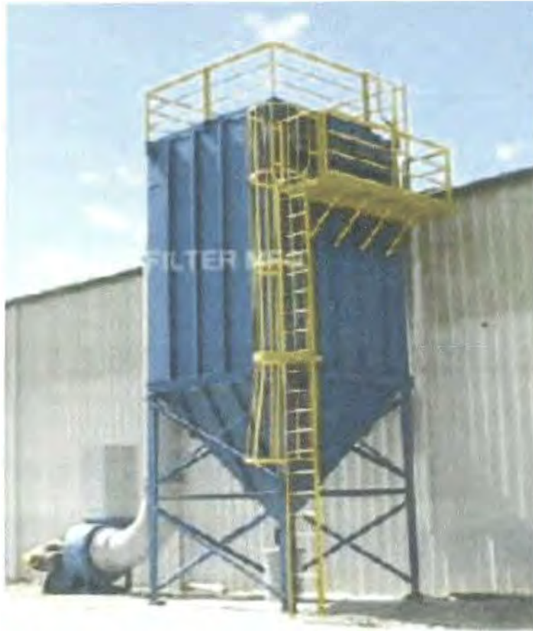
Figura 2.5 Colector de polvo
