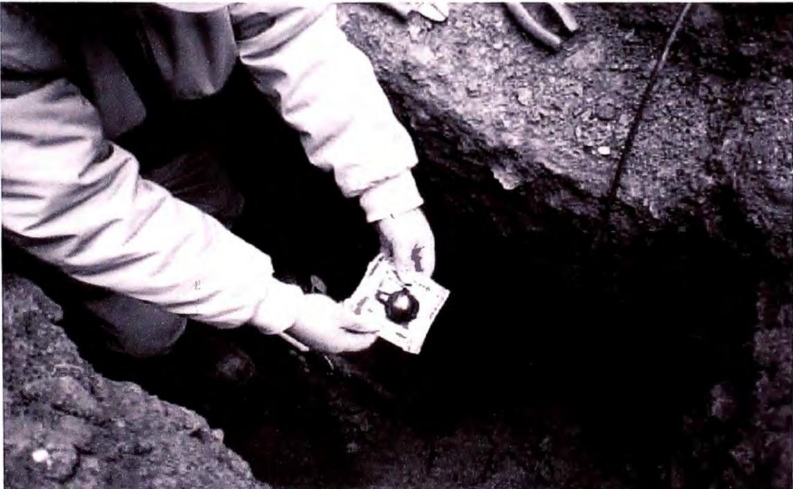
**Foto N°3 Instalación Anodos de Magnesio**
