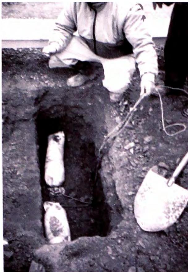
**Foto N°4      Cableado Anodos de Magnesio**
