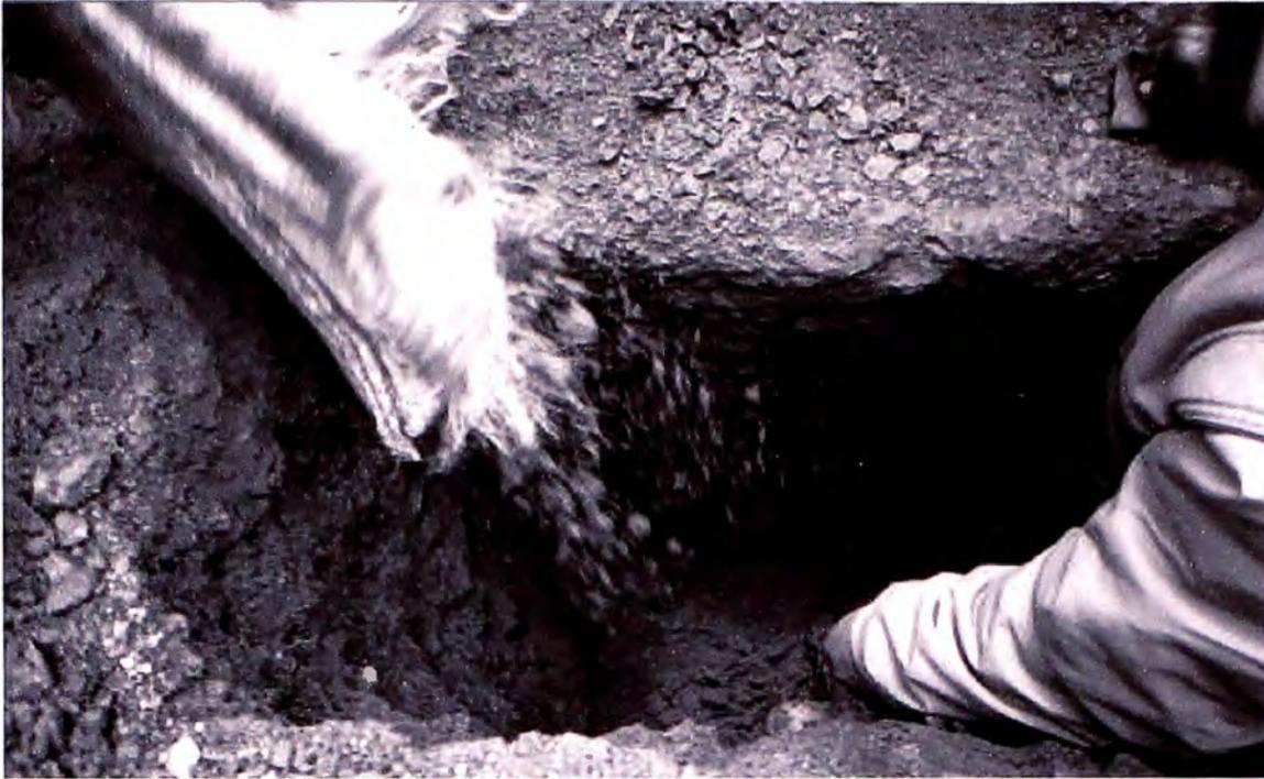
**Foto N°6 Tapado Final con Tierra de Cultivo - Anodos de Magnesio**
