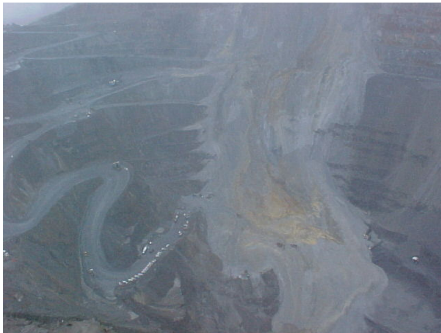
Fotografía 1.1 Falla de talud del tipo flujo, en la mina de cobre “Grasberg” de Indonesia.
