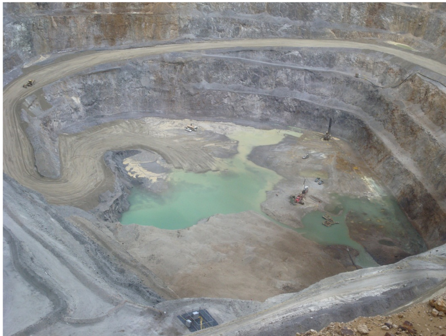
Fotografía 1.3 Acumulación de agua en el fondo del tajo Chaquicocha
