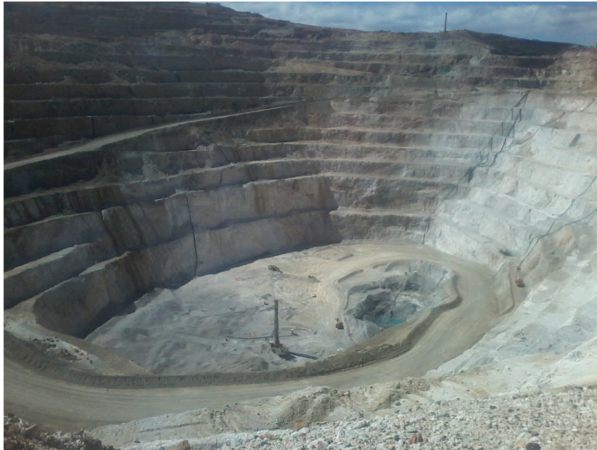
Fotografía 1.4 Presencia de agua en el fondo del tajo del Tapado Oeste
