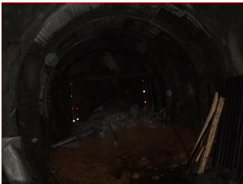
Figura 4.5 Aplicación de sostenimiento en crucero de producción (By Pass Nv. 4452)
