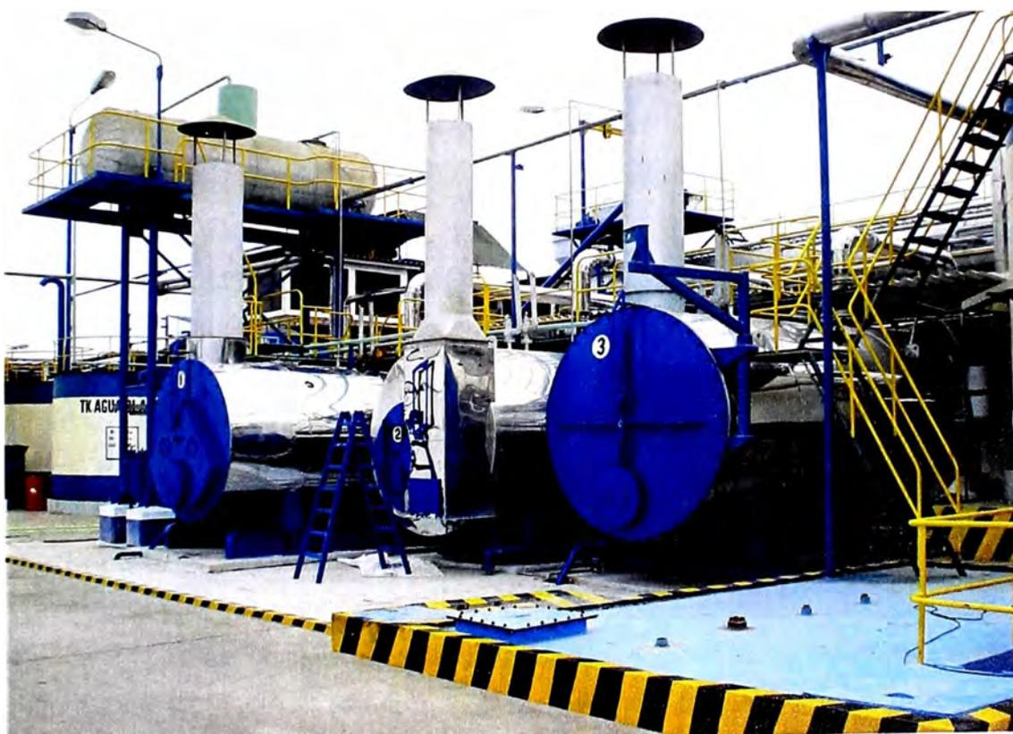
**Fig. 4.7** Vista posterior de las tres calderas de vapor en una veda de pescado
