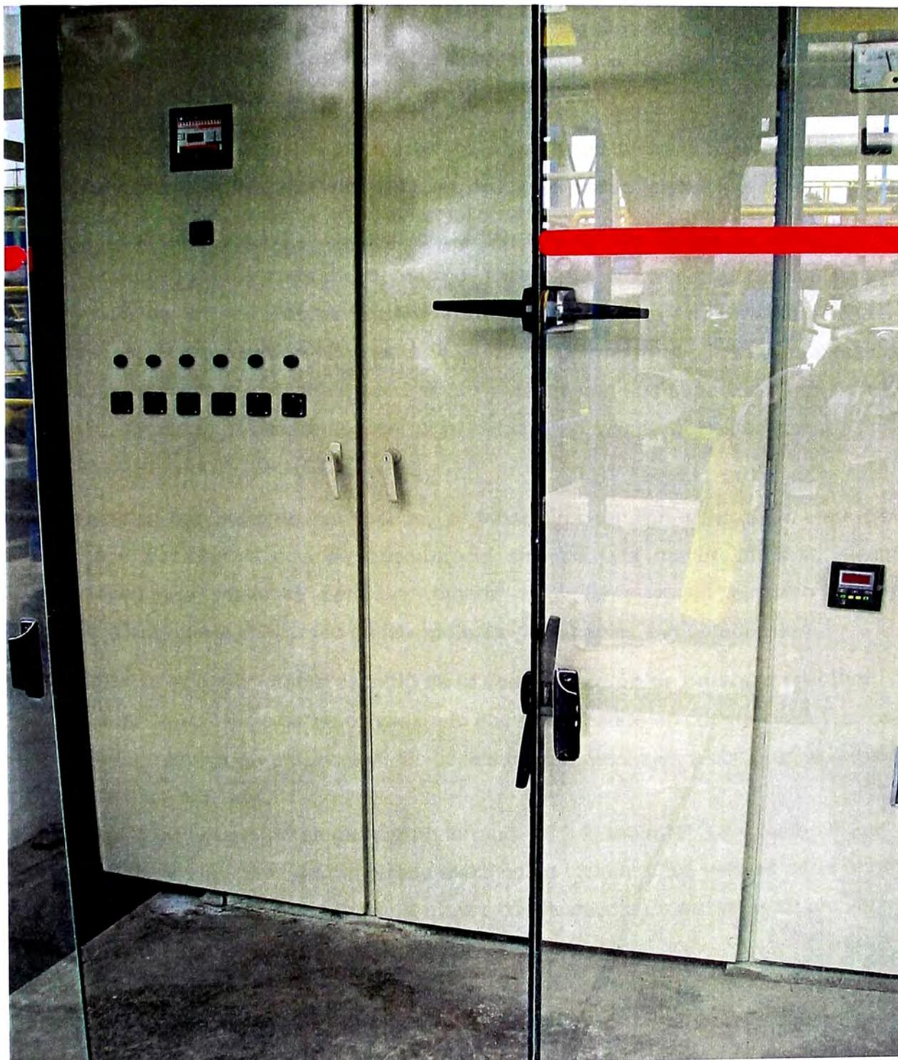
**Fig. 3.1** Vista del tablero TBC-1, que corresponde al banco automático de corrección del factor de potencia ubicado en la sub estación N° 1
