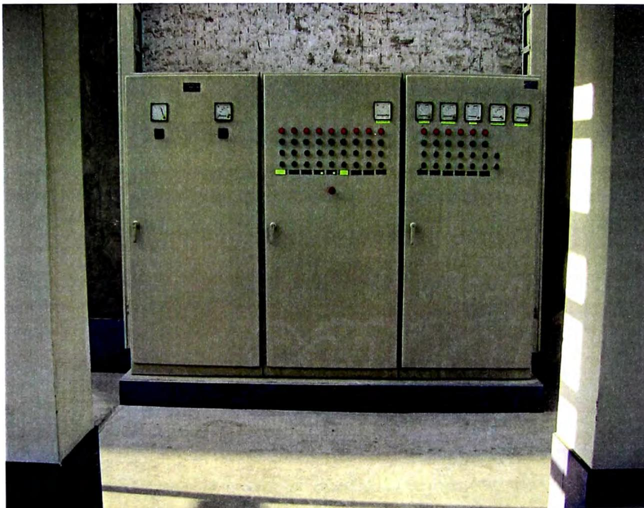
**Fig. 2.3** Vista del sub tablero STD-3, que corresponde a la zona de secado y molienda de harina de pescado.
