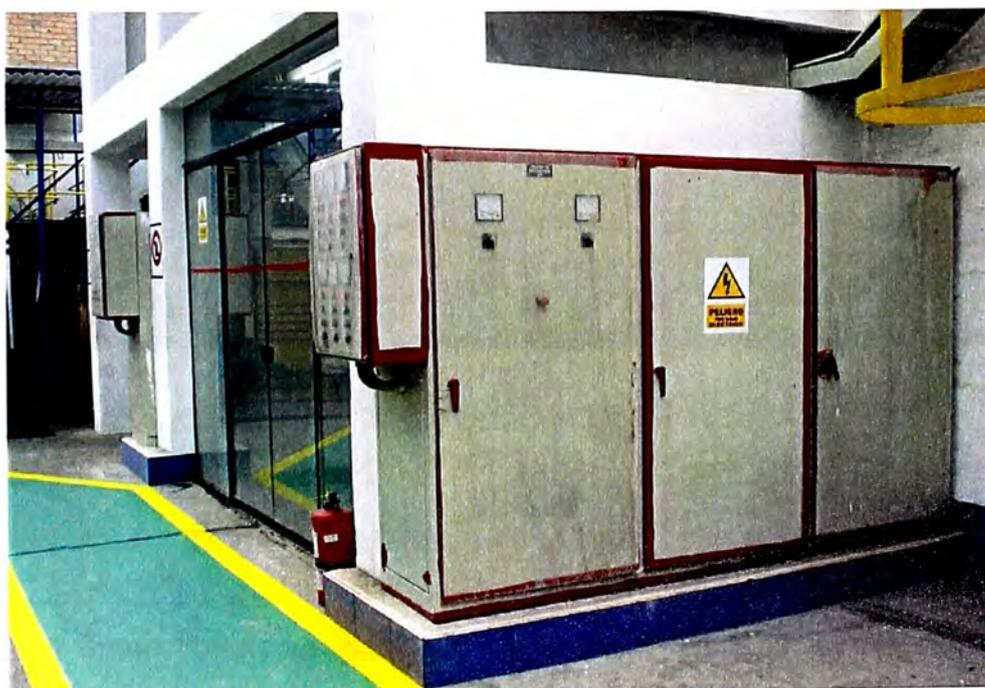
Fig. 2.1 tablero típico auto soportado STD-1
