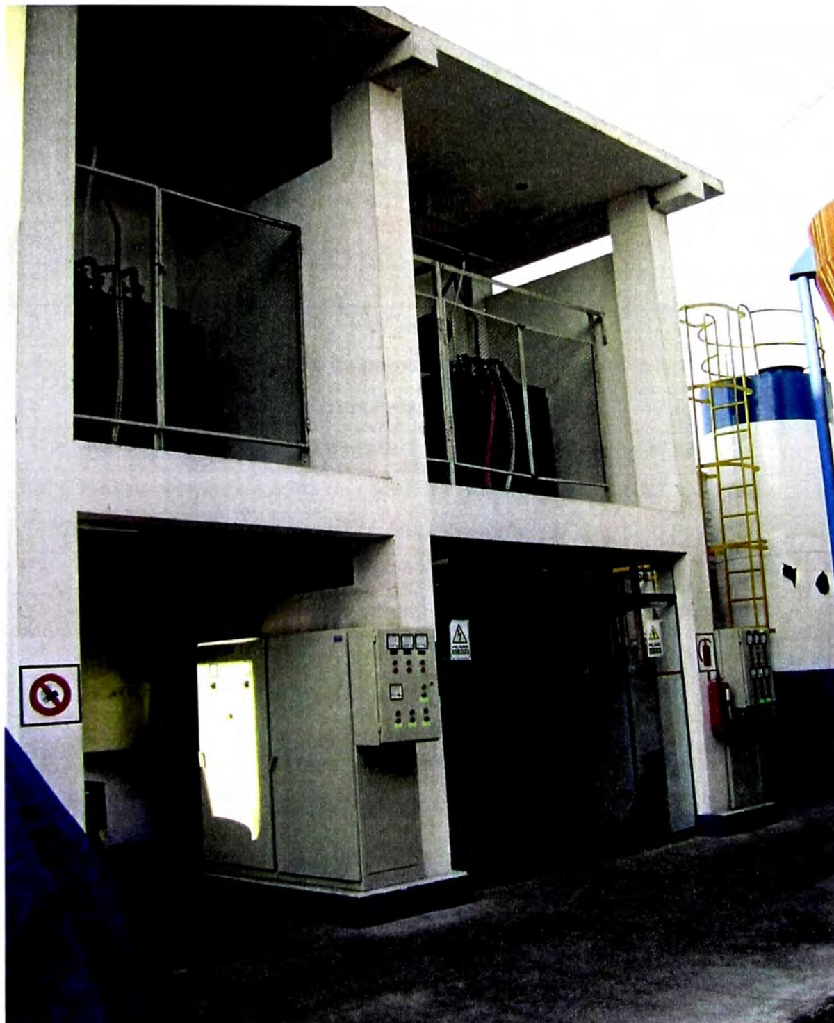
**Fig. 2.2** Vista de la sub estación N° 1 – 13.2/0.460 kV.
