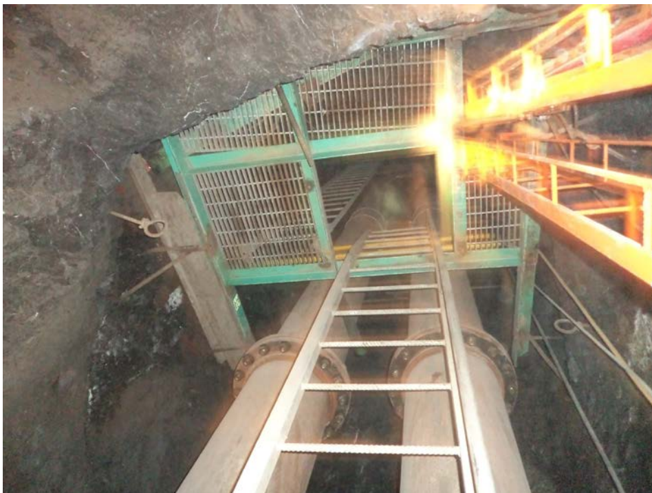
FIGURA 48. PLATAFORMA EN RAISE CLIMBER DE DESCARGA
