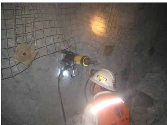
Prueba de arranque del Hydrabolt arranque instalado
