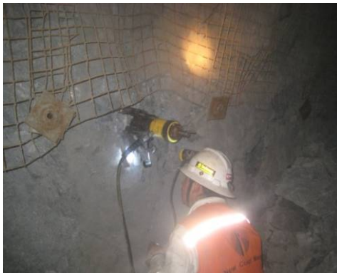
Prueba de arranque del Hydrabolt instalado
