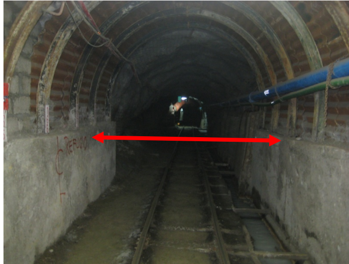
Fig. N° 68 Medida de la convergencia
