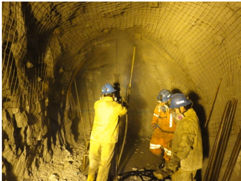
Fig. N° 48. Malla electrosoldada instalada
