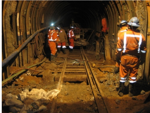
Fig. 54. Instalación de Cimbras 6W20
