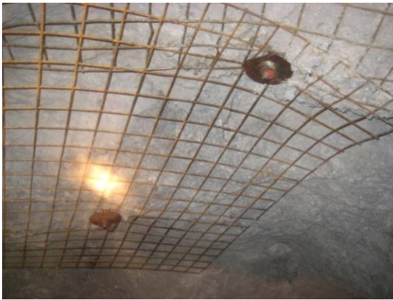
Correcta distribución del Hydrabolt en la la malla electrosoldada
