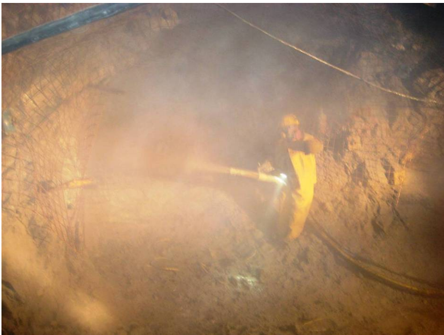
Foto 09: Tener en cuenta por tratarse de un sistema lanzado por vía seca se genera mucha polución y se tiene muy poca visibilidad
