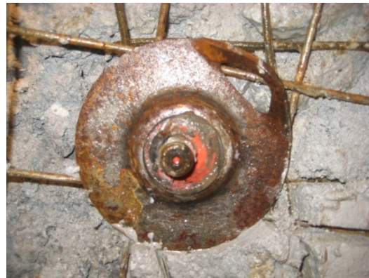
Correcto sellado de electrosoldadas con el Hydrabolt
