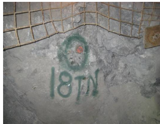
Resultado de la prueba de de un Hydrabolt bien instalado
