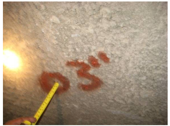
Medición de espesor de shotcrete
