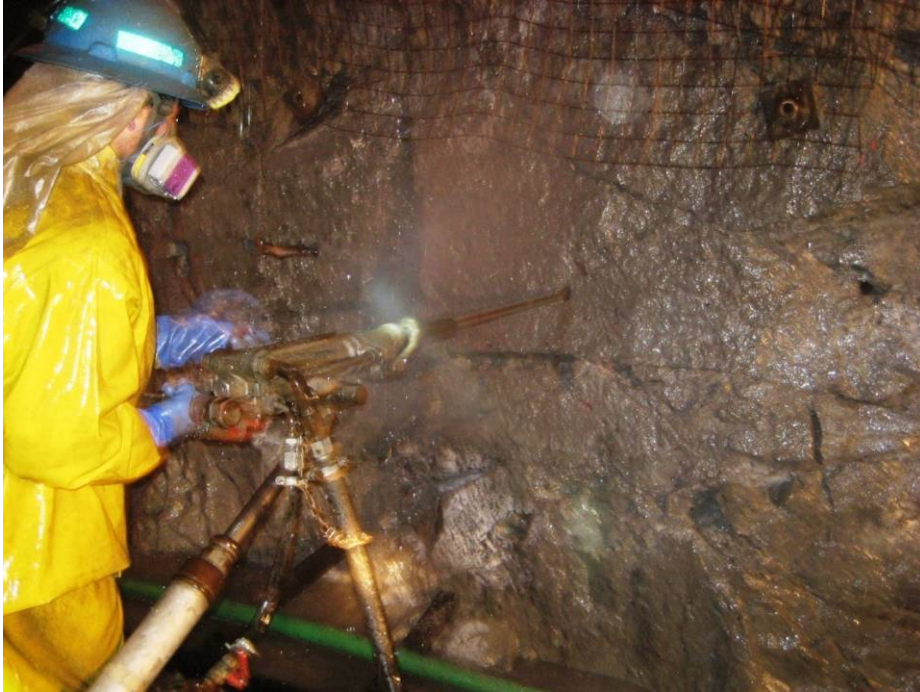
FOTO 06: BATIDO DE LOS CARTUCHOS CON LA BARRA HELICOIDAL (INSTALACIÓN)
