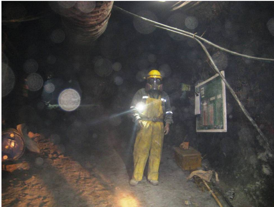
Foto 08: Se debe realizar pruebas de EPP adecuado por las E.E. para el personal Involucrado en el lanzado de concreto.
