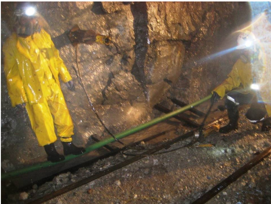
FOTO 07: PRUEBA DE TRACCIÓN DE PERNOS (PRUEBA DE ARRANQUE)
