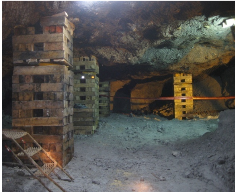
Fig. N° 64 Armado de Jack pack
