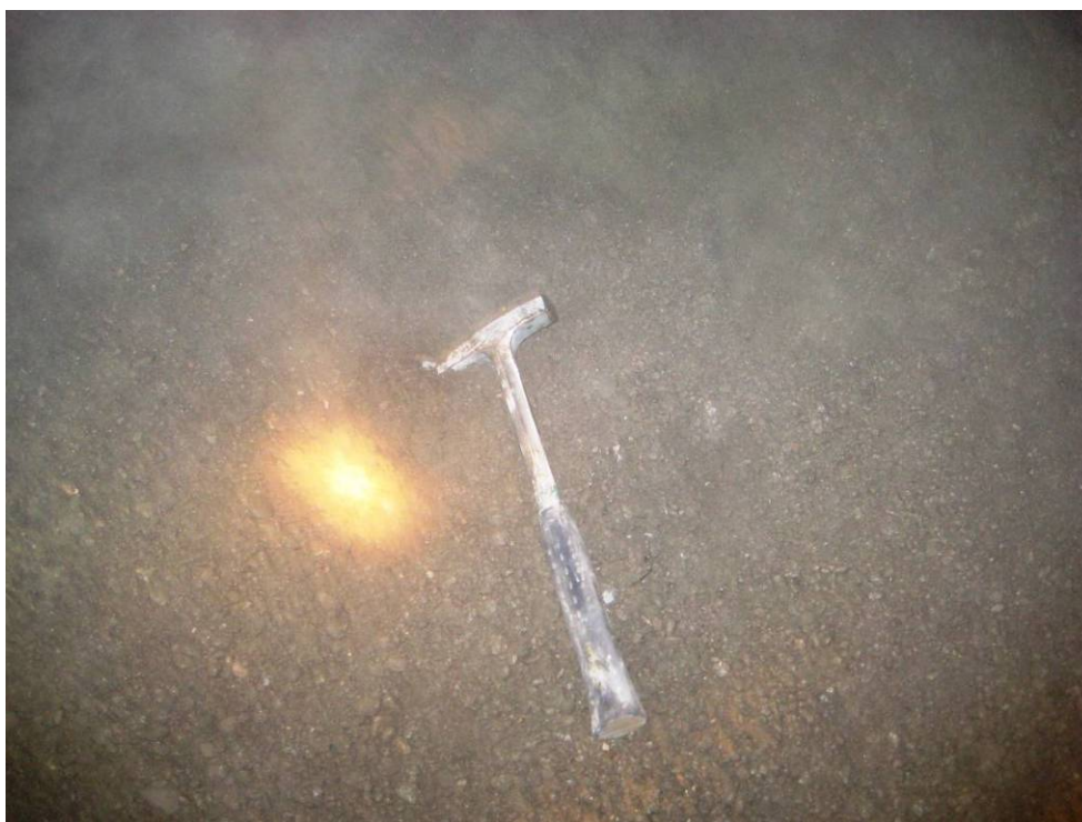
Foto 10: Observar que rebote o rechazo de arena gruesa al final de la jornada del trabajo de concreto lanzado
