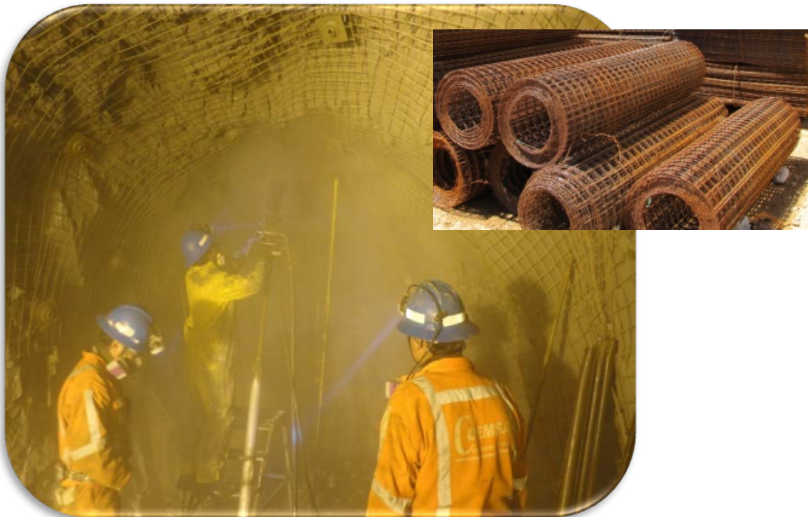
Fig. N° 49 Instalación de malla electrosodada en rollo.
