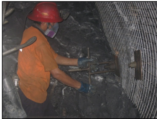
Fig. N° 43 Ajuste de los pernos Helicoidales
