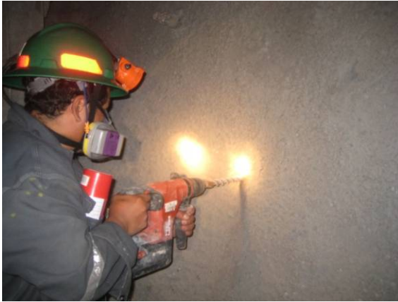
Verificación de espesor de Shotcrete
