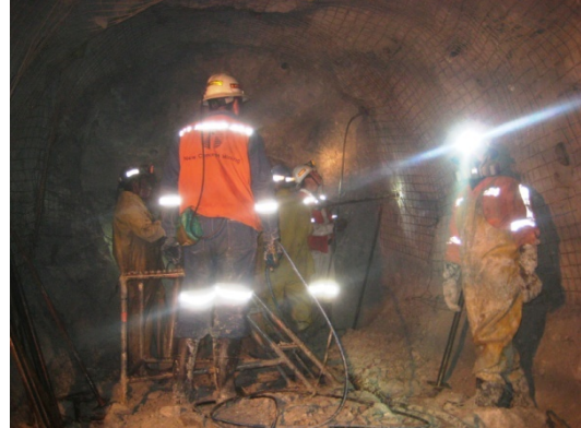
El personal es capacitado sobre correcto instalado del Hydrabolt
