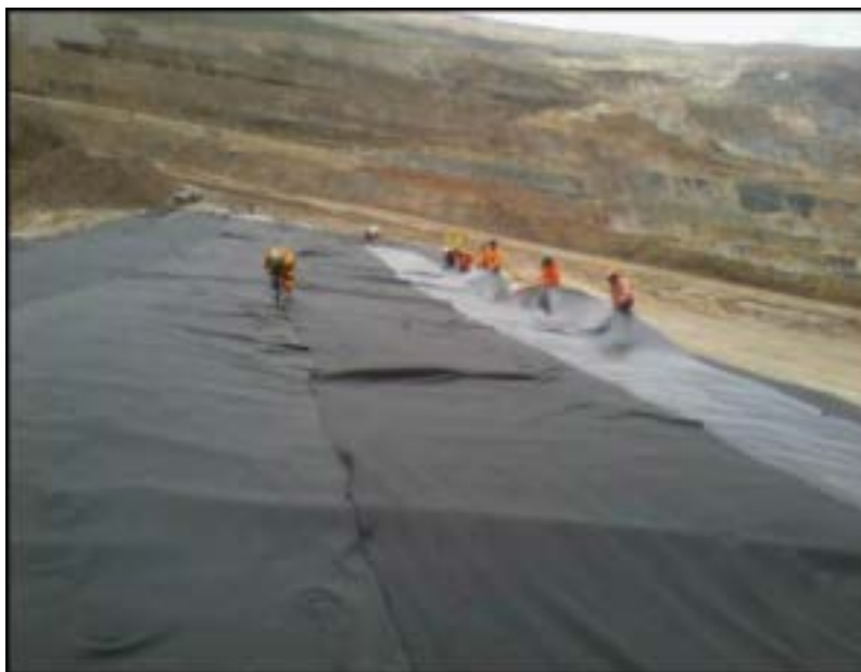
Figura 13. Colocación de la geo-membrana sobre la primera capa de geotextil de protección.
