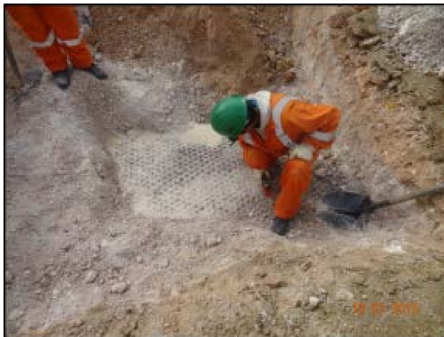
Figura 18. Exhumación de la geo-malla multiaxial dentro de la Capa de Rodadura
