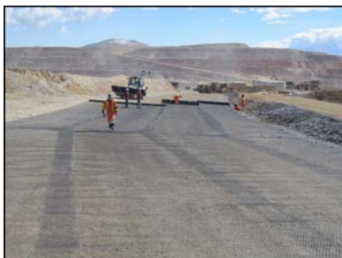
Figura 15. Colocación de la geomalla sobre la primera capa de material de rodadura.
