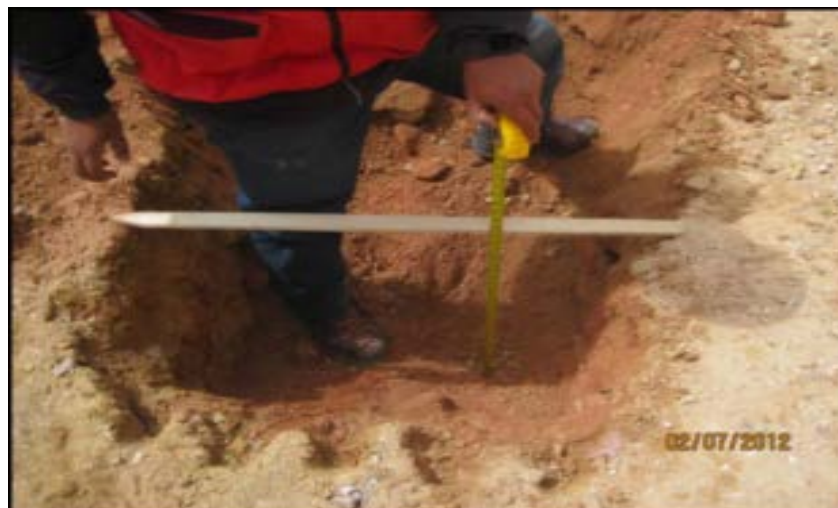
Figura 17. Medición del espesor compactado por el paso de los vehículos de acarreo minero
