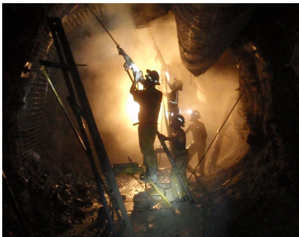
Figura 2.1 Sostenimiento CX 430S, U.E.A. Orcopampa.
