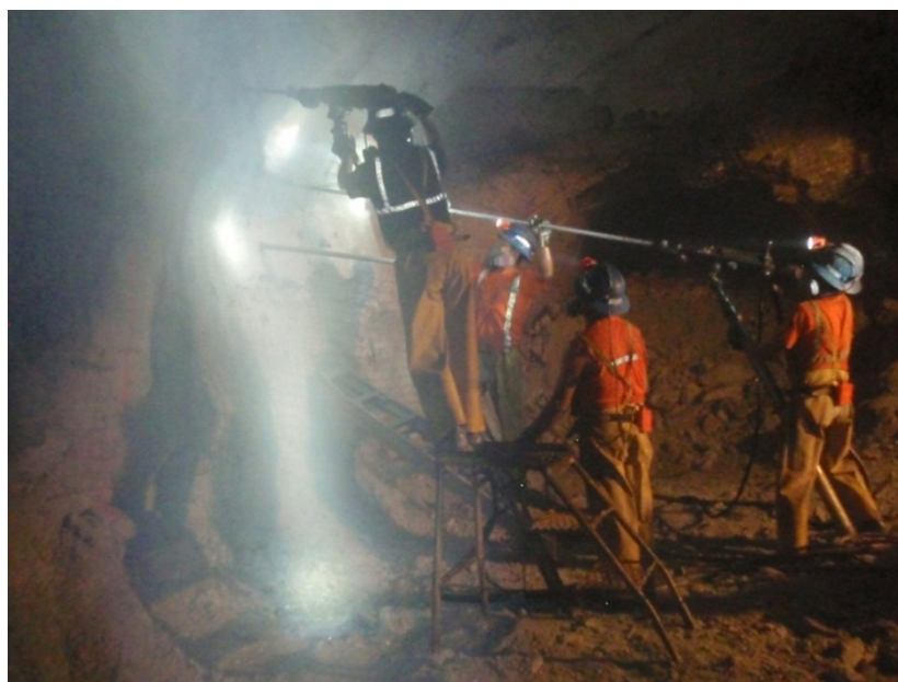
Figura 2.6 Perforación con jack-leg, CX 430 S.
