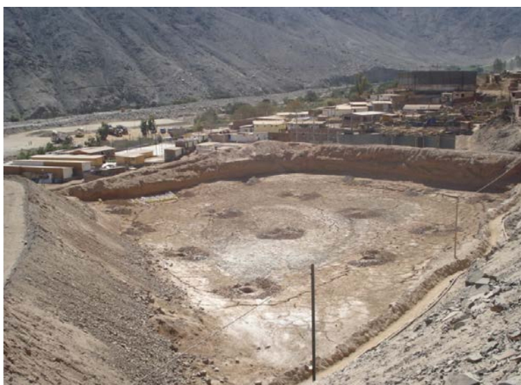
Figura N° 4.4 Cancha de relave N° 1
