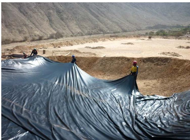
Figura N° 4.13 Colocación de la geomembrana
