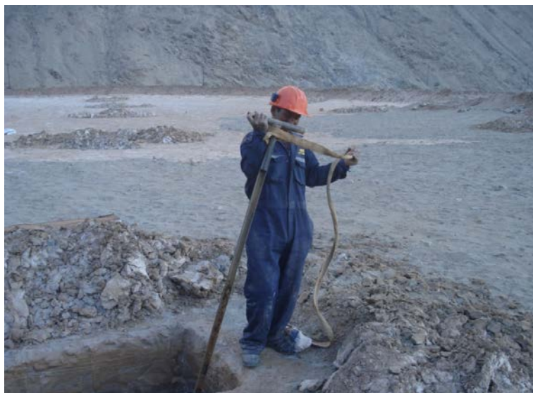
Figura N° 4.7 Poza de 6m de profundidad
