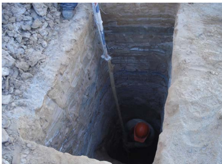
Figura N° 4.6 Excavación de poza
