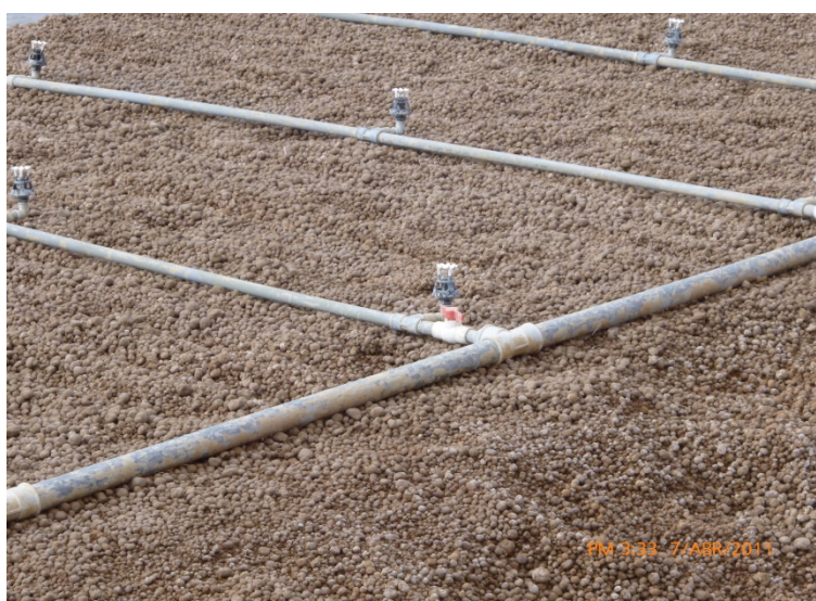
Figura N° 4.18 Riego del Pad
