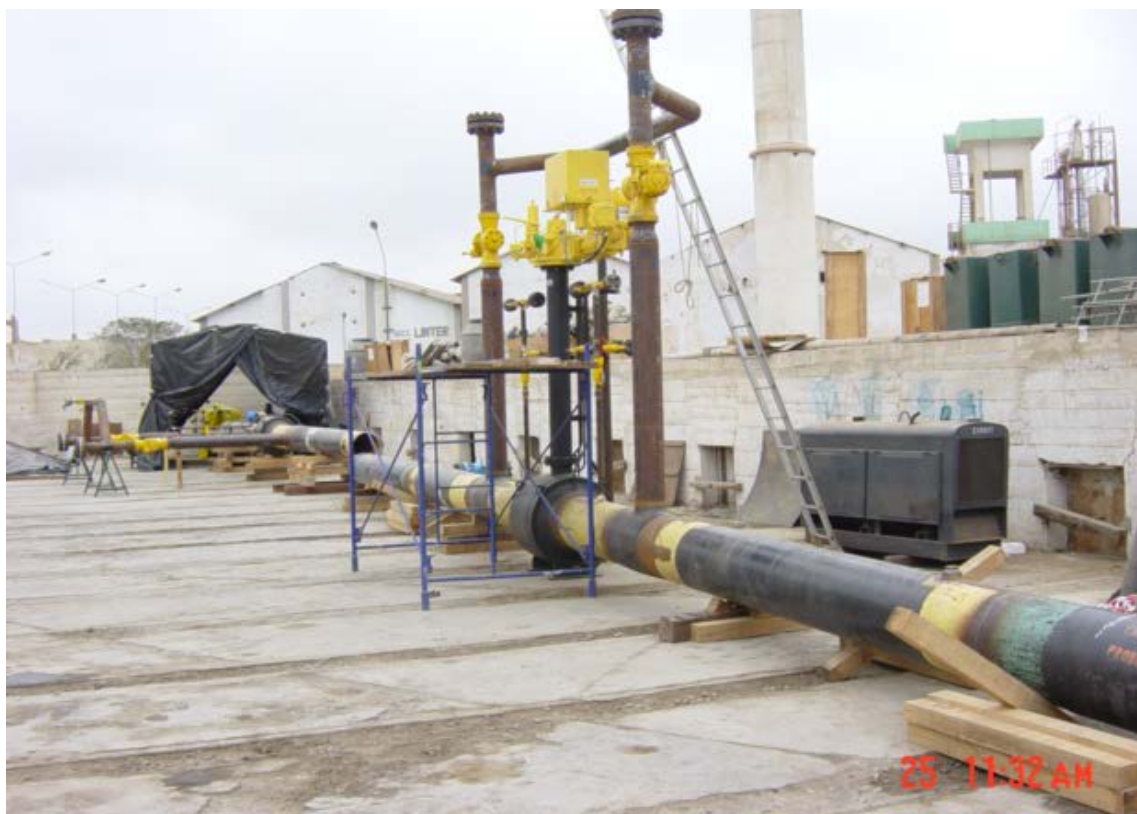
Figura 6.9.1 Instalación de Válvulas
