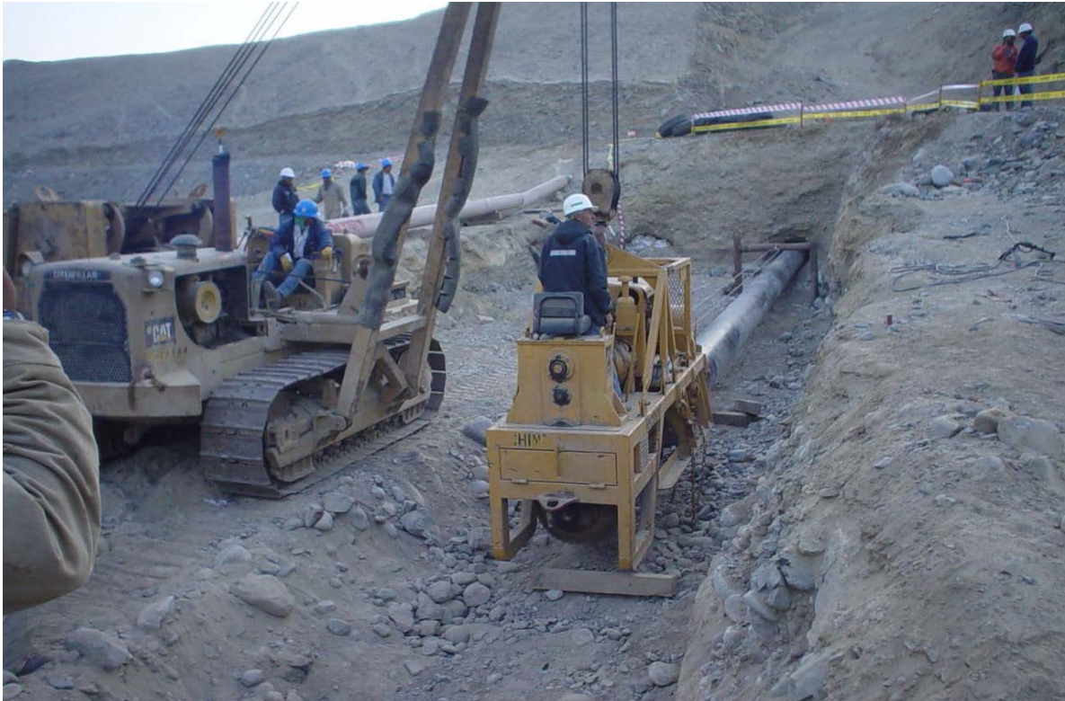
Figura 6.8.3 Cruce de Carretera
