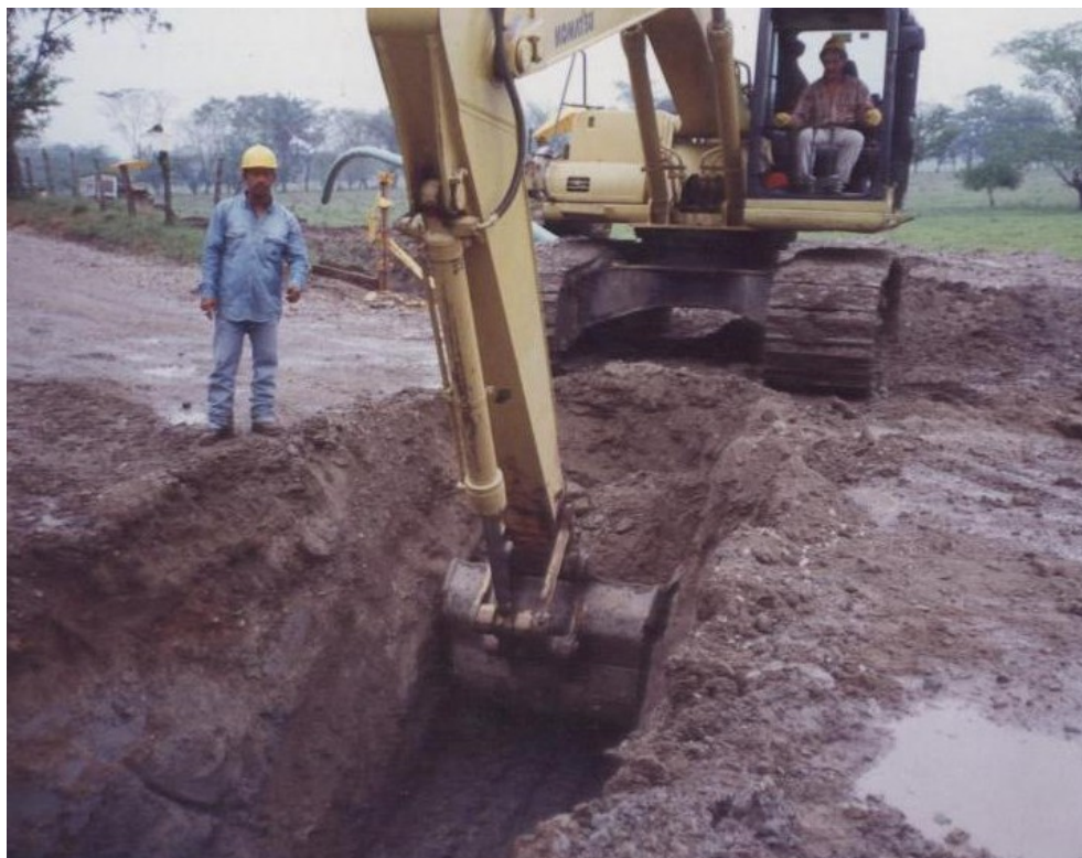
Operaciones de Zanjado
