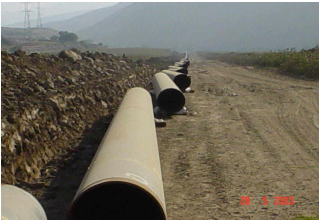
Figura 4.7.3 Riego de Tuberías
