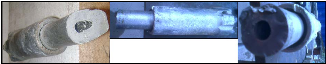
FIGURA 97: ROTURA EN EL CUERPO DE LA BARRA
