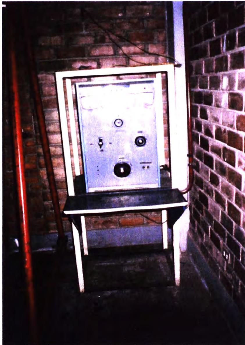
**Fig.4.3: Tablero electrónico que presenta un regulador de velocidad del motor**
