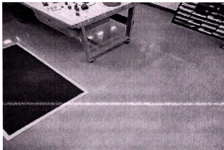
Fig 1.6 : Sala Técnica con piso conductivo
