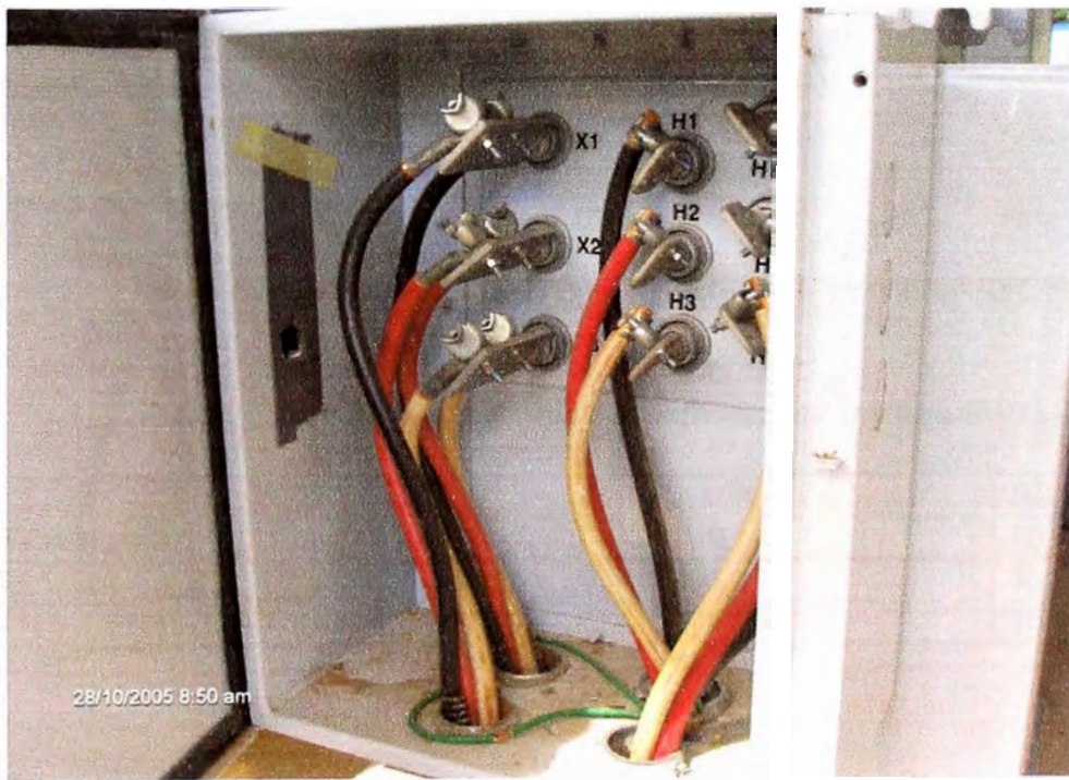
Figura C.2: Acometidas al Transformador Desfasador 1000kVA
