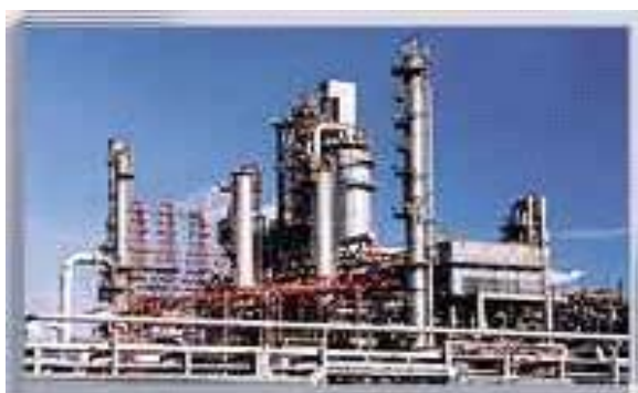
Figura 1: Vista Típica de una Refinería
