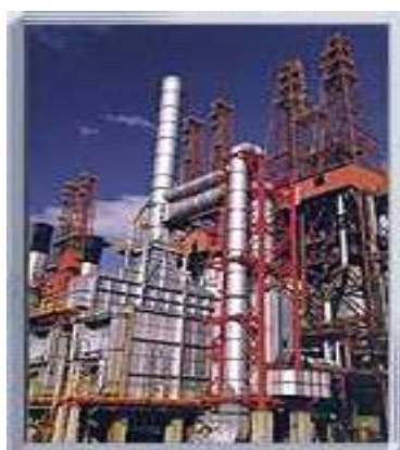
Figura 5: Planta de Concentración de Gases
