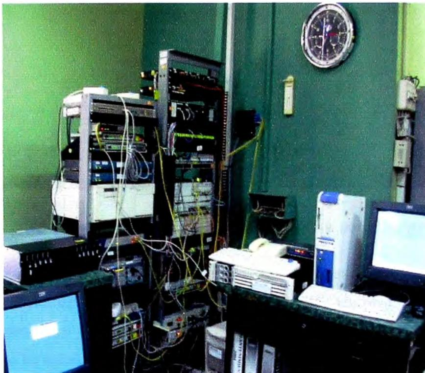
Fig. 2.2 Sala de Máquina: medidor de temperatura y humedad relativa.
