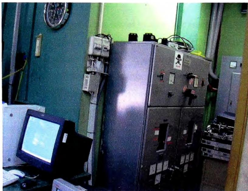
Fig. 2.6 Llaves termomagnéticas de la energía estabilizada.
