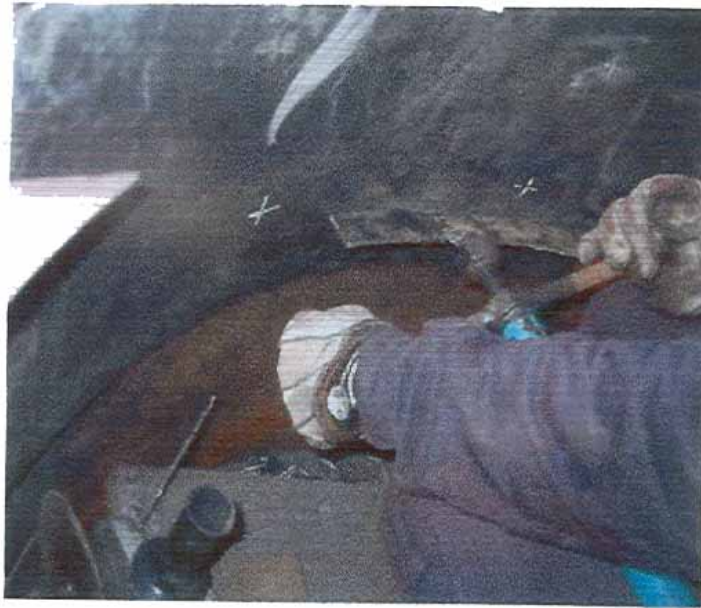
Foto N°11. Aplicación de un tensor para garantizar la adherencia del Lining de Monel al casco de la Columna.
