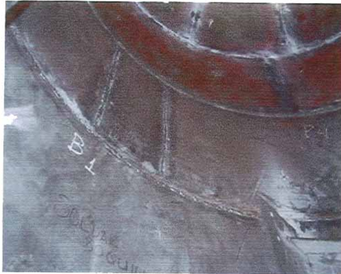
Foto N°14. Aplicación final de Lining de Monel en el cilindro de la Columna.
