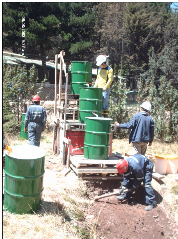
Foto 3.1.- Construcción de reactor bach
