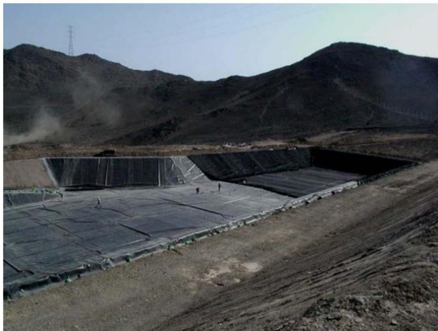
Figura N° 1.2. Instalación del geotextil de protección en la base y paredes laterales del depósito de seguridad.
