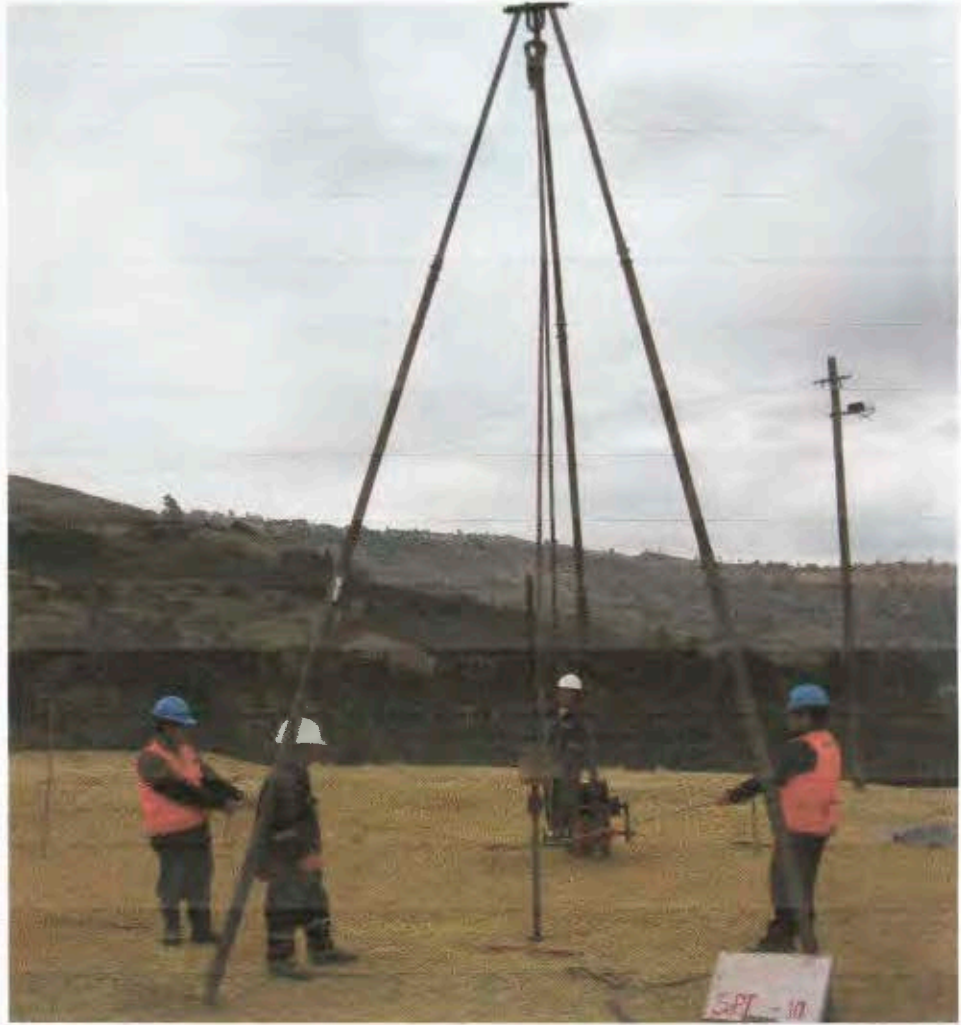
EQUIPO DE PERFORACIÓN SPT EN TRABAJO
