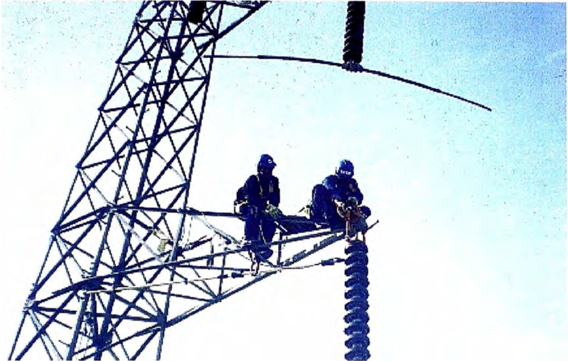
Foto (7.7) – Acople del “Sujetador de Estructura” a la chapa del extremo de la ménsula
