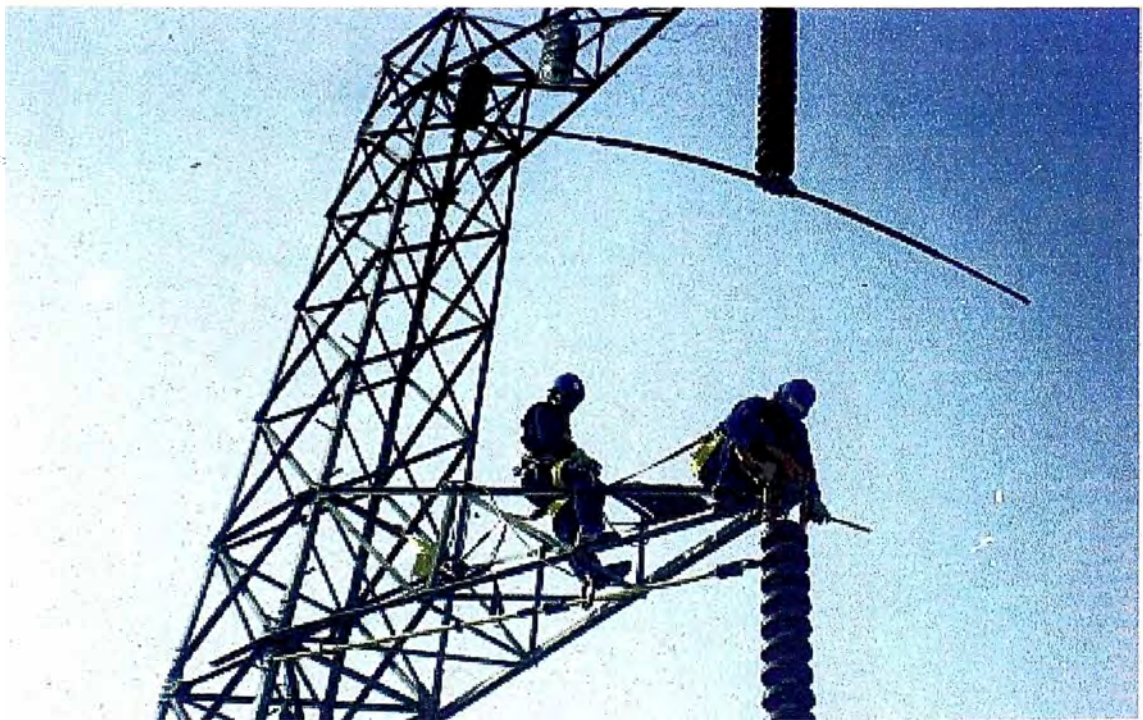
Foto (7.8) – Accionamiento de las manijas para jalar la cadena hacia sí, se verifica que ambos torniquetes tienen la misma tirantez
