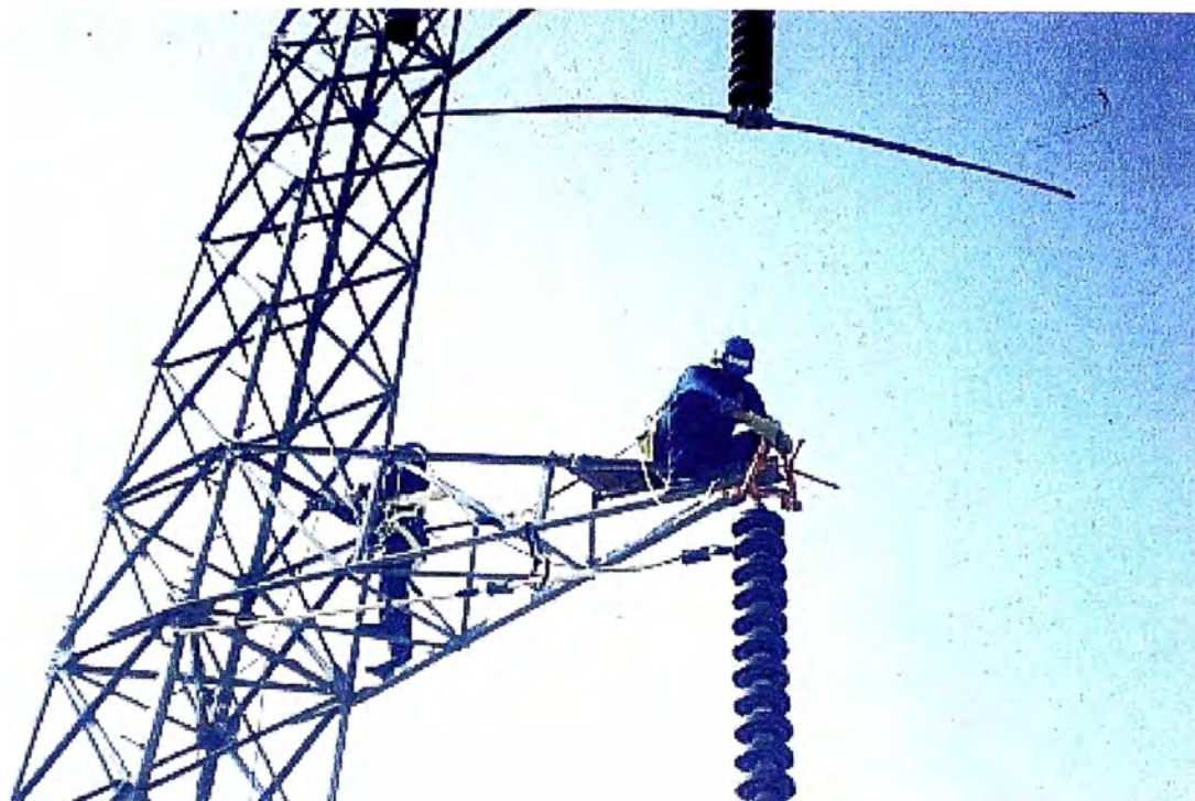
Foto (7.5) – Colocación del “Sujetador De Estructura” con los dos “Torniquetes” al primer aislador
