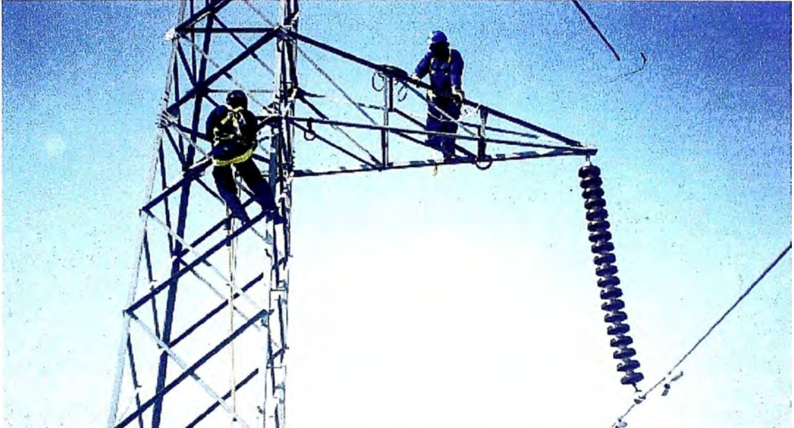
Foto (7.1) – Instalación de polea y soga de servicio por el interior de la estructura para evitar acercamiento hacia el conductor.
