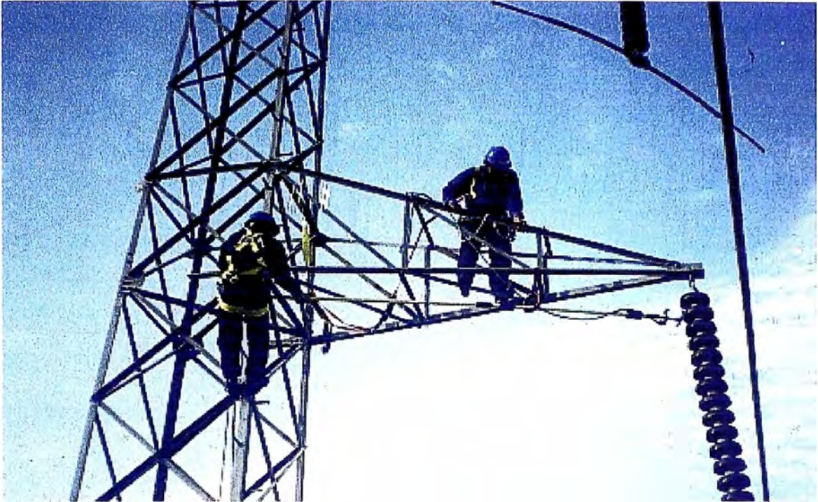
Foto (7.3) – Conexión de la tierra temporaria en la caperuza del segundo aislador.
