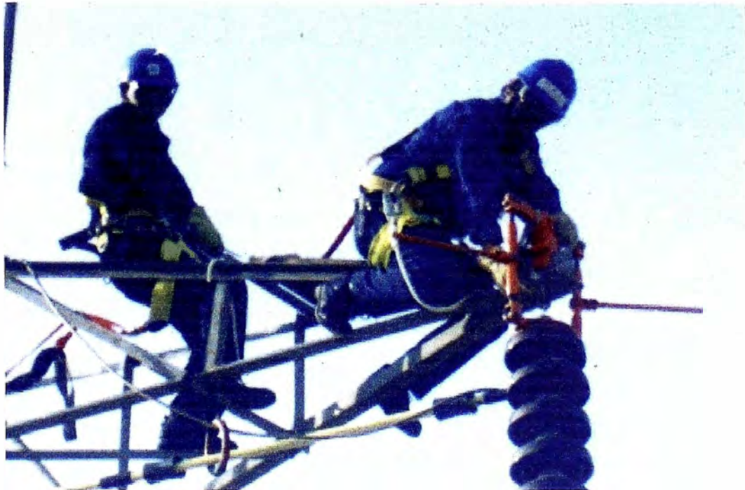
Foto (7.10) - Extraído la chaveta, queda libre la ferretería a cambiar (Ojal Bola, Perno Pasante en “U”, etc. )
