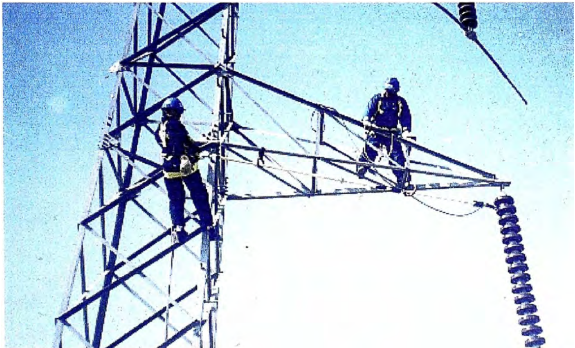
Foto (7.4) – Concluido la instalación de la tierra temporaria, se da inicio a las labores de instalar los demás equipos.
