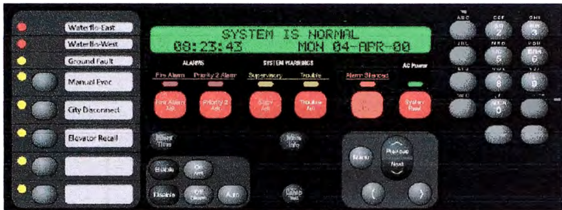
Figura 4.3 Interfase del panel de control con el usuario
