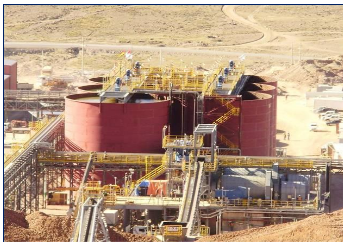
Figura N° 10: Lixiviación por agitación
