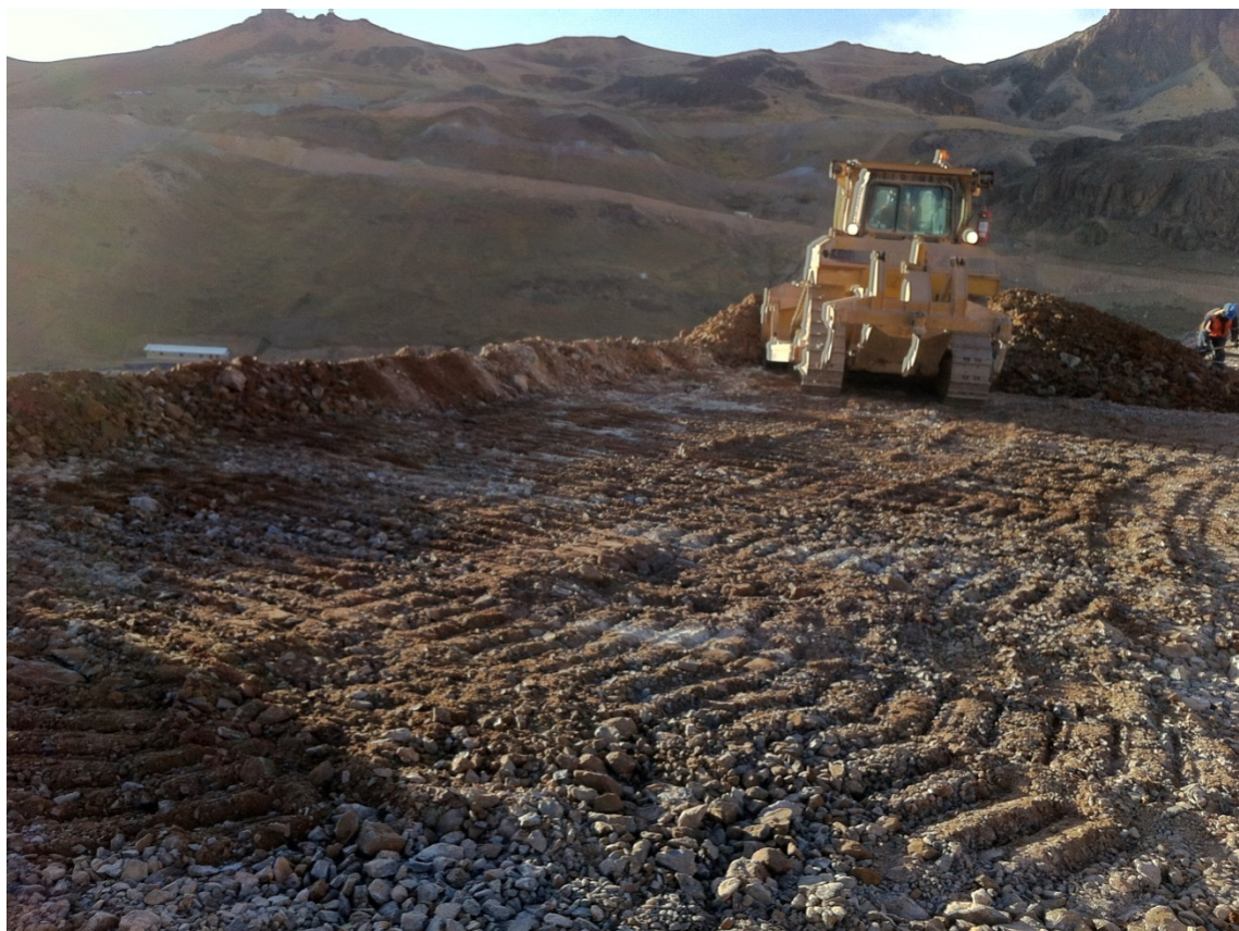
Figura 4.2 Adición de cal y empuje de mineral.
