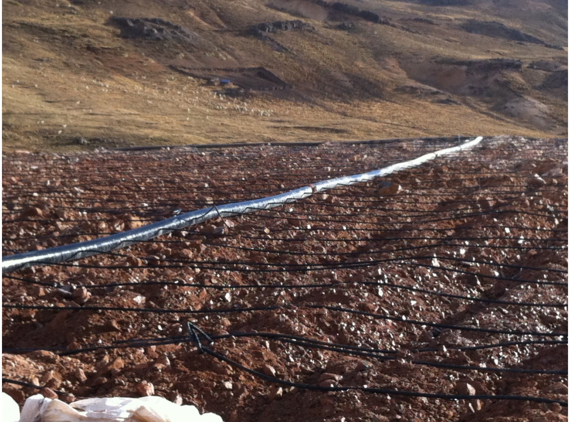
Figura 4.4. Tendido de mangueras en módulo nivelado.
