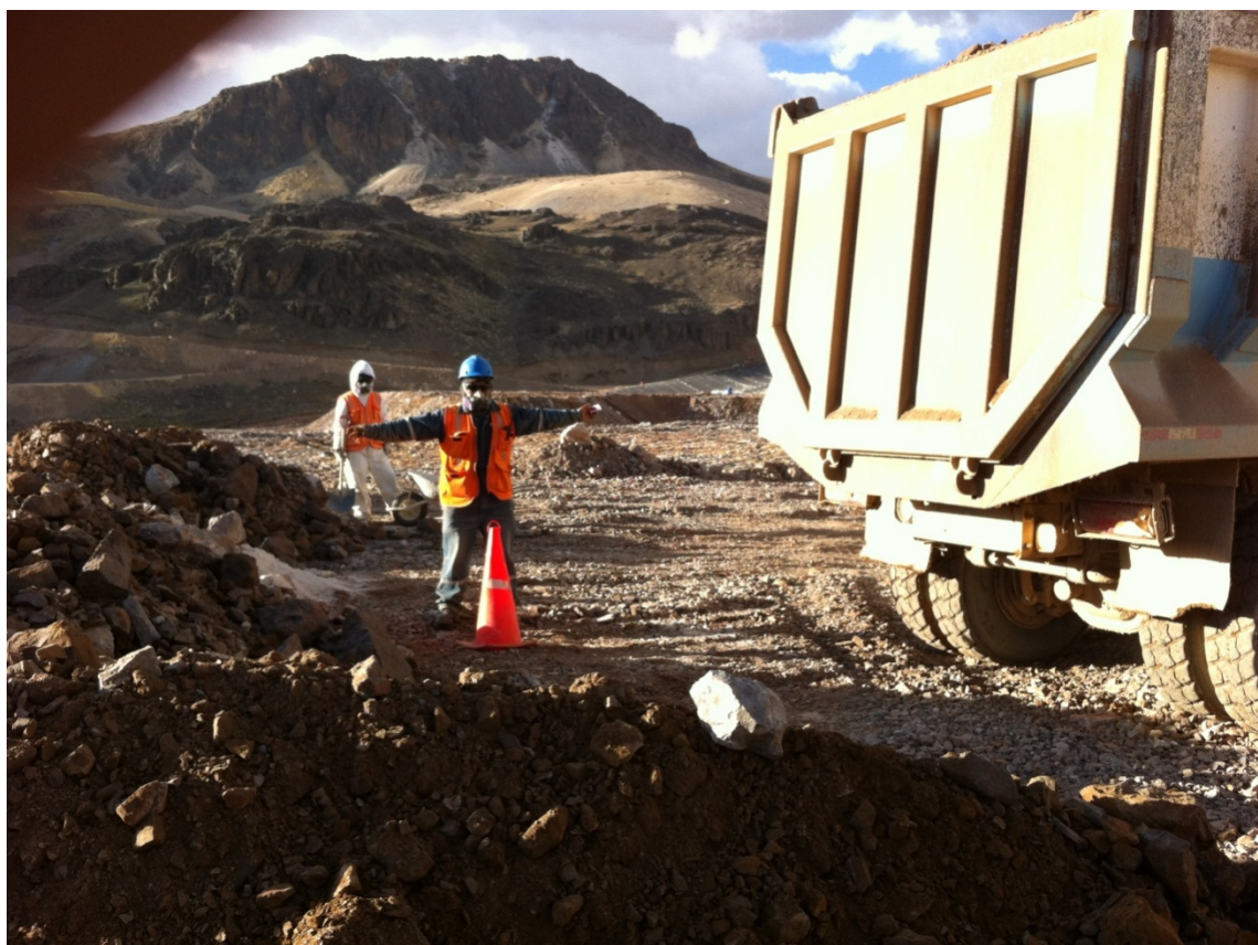
Figura 4.1 Descarga del mineral para el armado de módulos.
