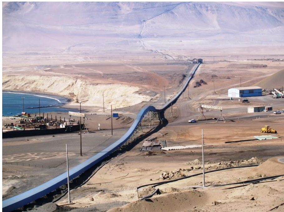
Fotografía 5.5. Faja transportadora de crudos de mina a plantas de beneficio en San Nicolás.
