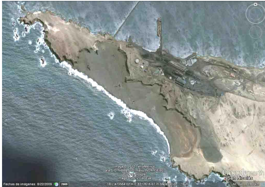
Fotografía 8.2. Vista panorámica de la relavera “San Juanito”.
