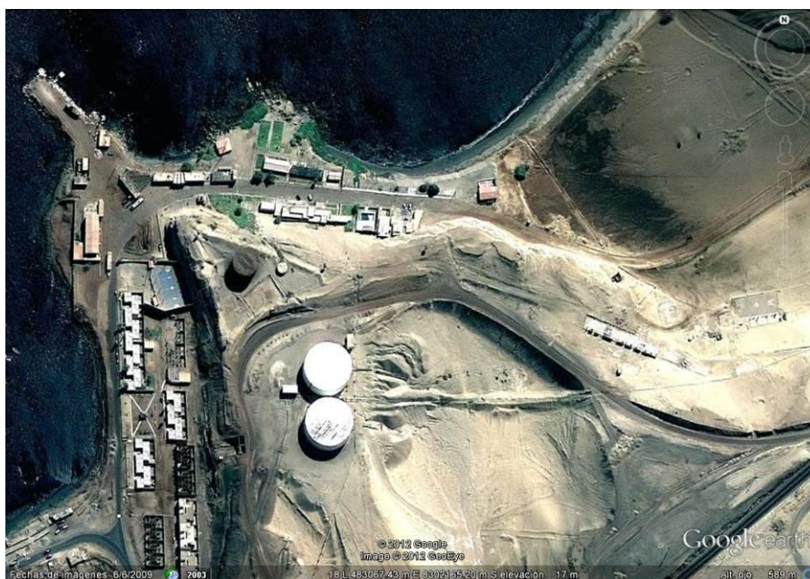
Fotografía A1.3. Vista panorámica: Villa Naval y tanques de agua dulce.
