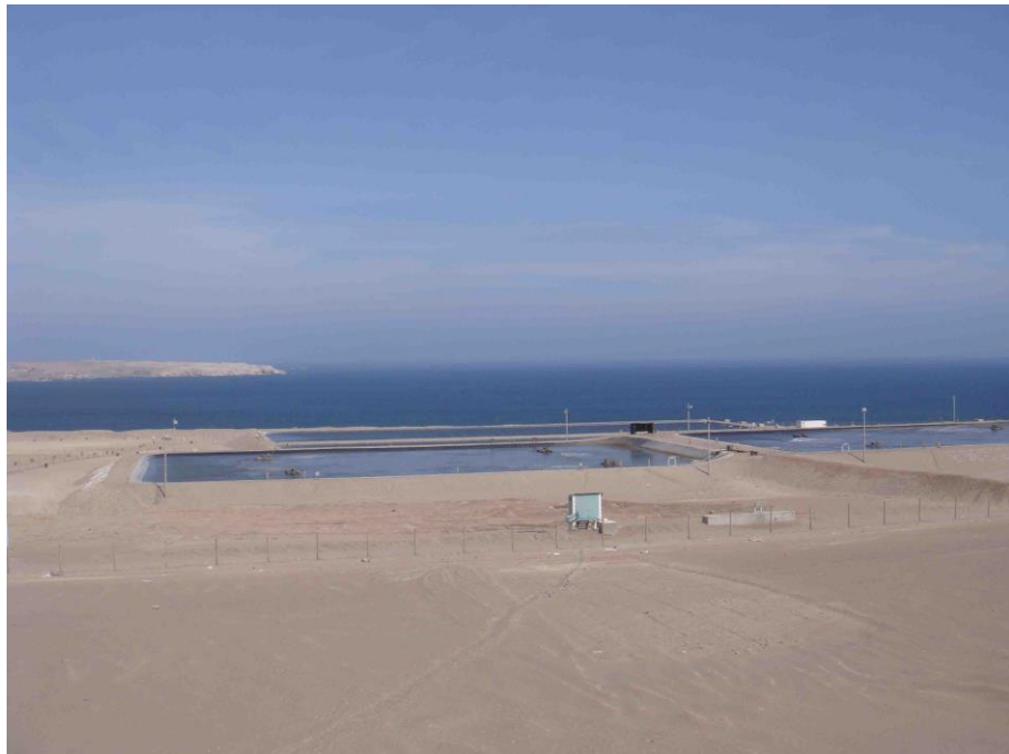
Fotografía 4.2. Planta de tratamiento de aguas residuales.
