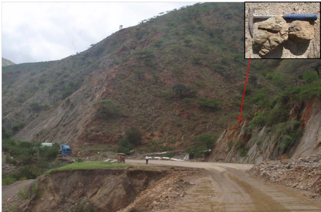
Foto 1: Vista al Noroeste. Complejo Olmos, en la localidad de Ochentiuno-San Felipe-Jaén.
