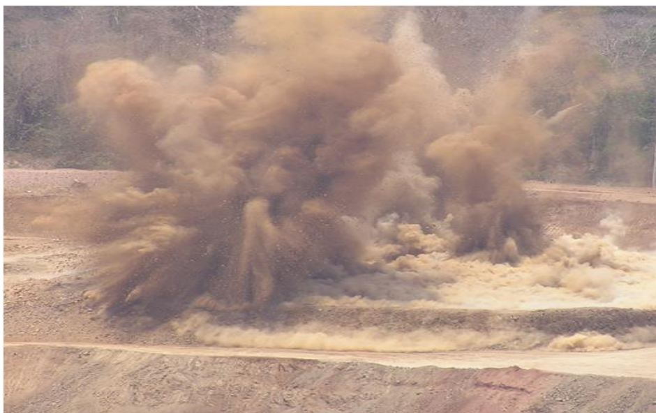
Figura N° 6.1: En la cual se puede observar el polvo producido por la voladura de rocas.
