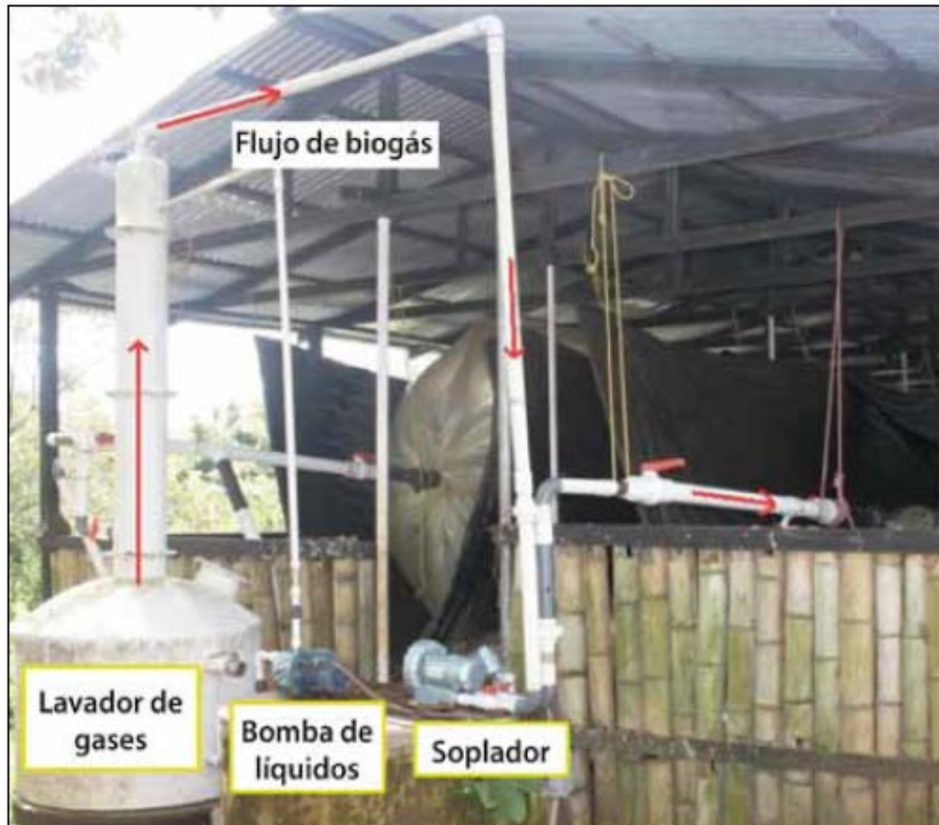
Figura 2.3 Lavador de gases ubicado en E.A.R.T.H. (Escuela de agricultura de la región tropical húmeda).
