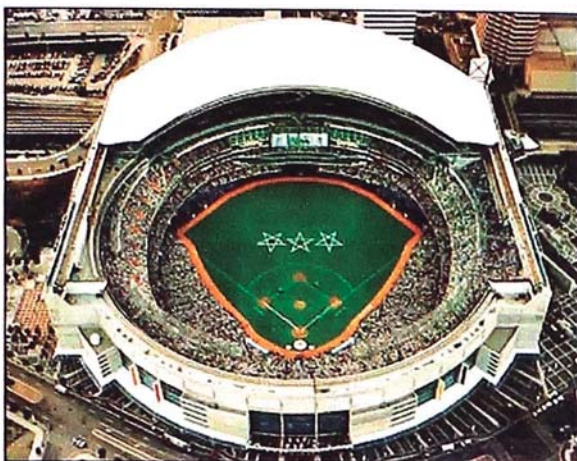
Figura 62. Vista del estadio con el techo replegado.
