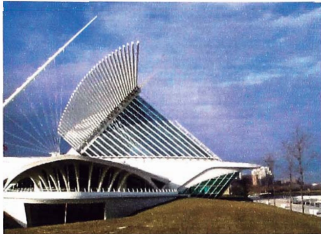
Figura 50. Vista peatonal con la estructura abierta.
