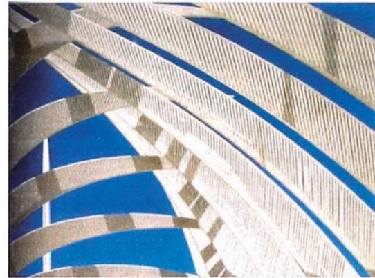
Figura 46. Detalle de la estructura
