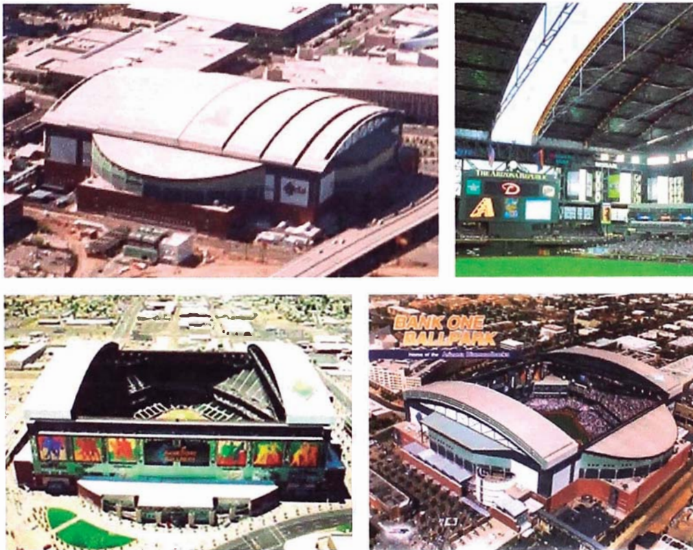
Figura 29. Secuencia de movimiento de la estructura del Bank One Ball Park (Phoenix, USA), de los arquitectos Ellerbe Becket y Bill Jonson (arriba)
