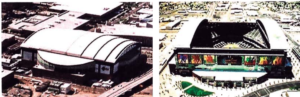
Figura 59. Vista aérea del estadio con el techo cerrado (arriba izquierda) y con el techo abierto (Arriba derecha).
